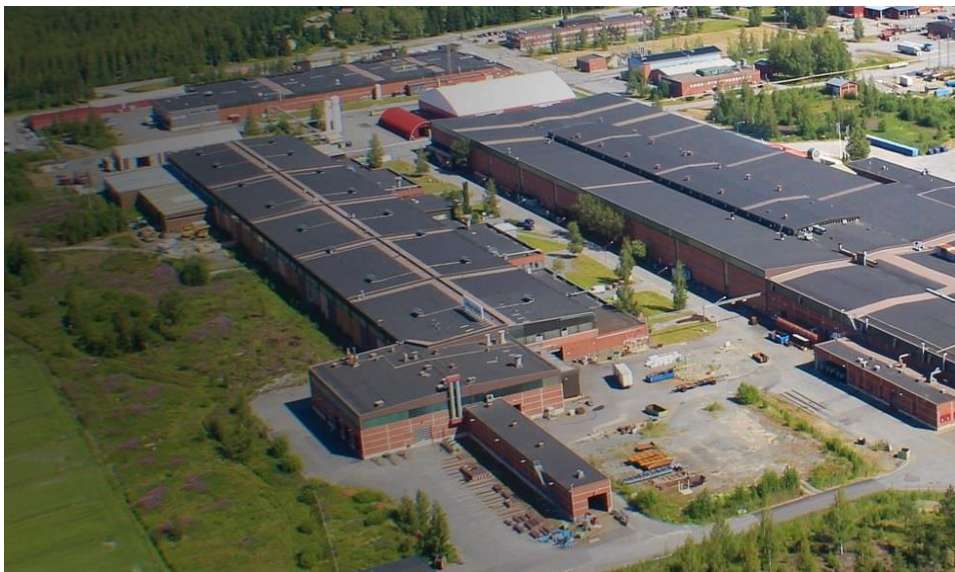
Kuva 2. Ilmakuva Aurubiksen kuparivalssaamosta. (Kupariteollisuuspuiston www-sivut 2020.)
