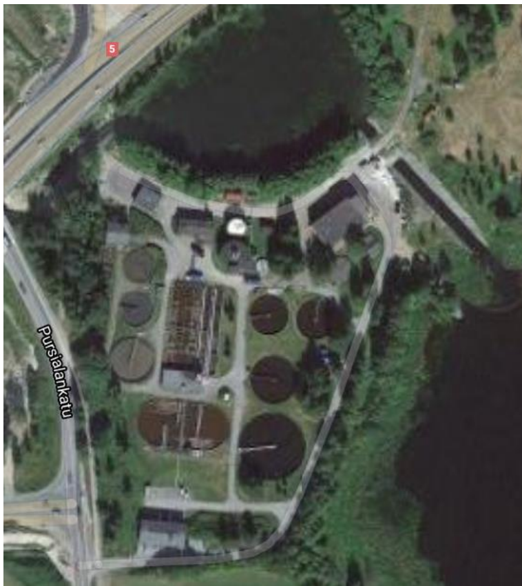
Kuva 4 Kenkäveronniemen jätevedenpuhdistamon alue (Google Maps, 2020.)
