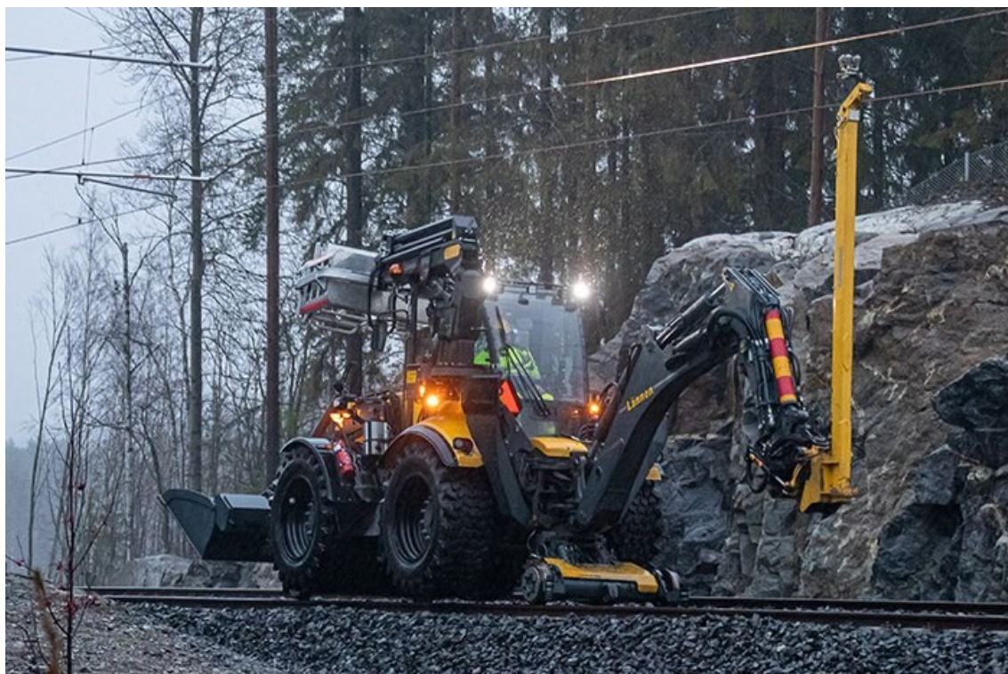
KUVA 5. Ratavarustuksella varustettu monitoimikone (Lännen Rail Systems 2020)
