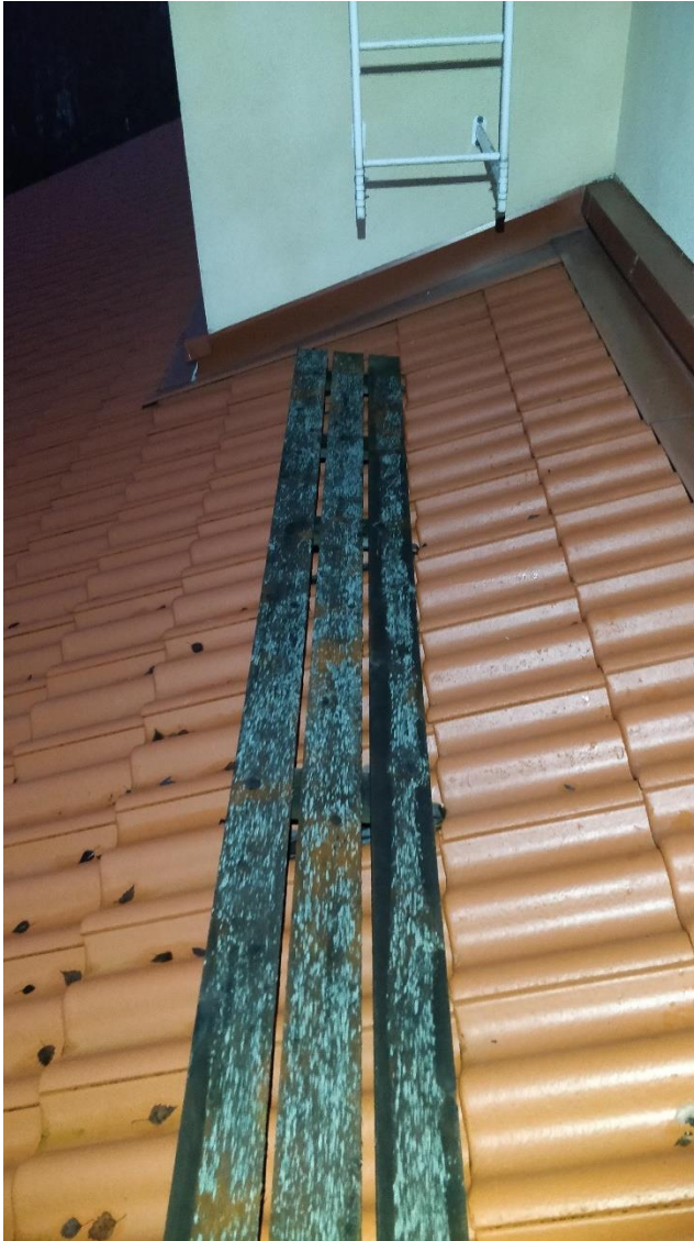
Kuva 7. Vesikate ja kulkusilta
