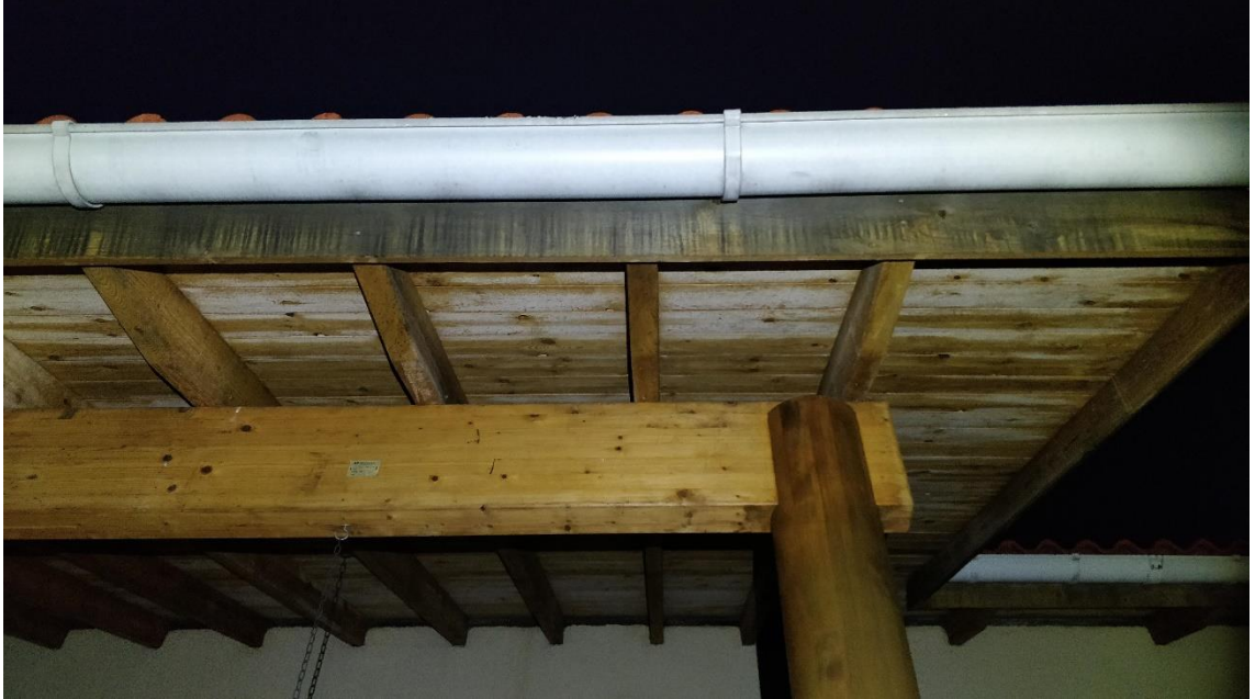
Kuva 2. Räystään alapuolinen lautaverhoilu
