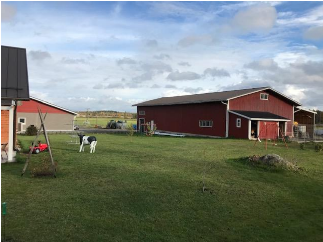
Kuva 4. Konehallin kattopinta-alaa on runsaasti.
