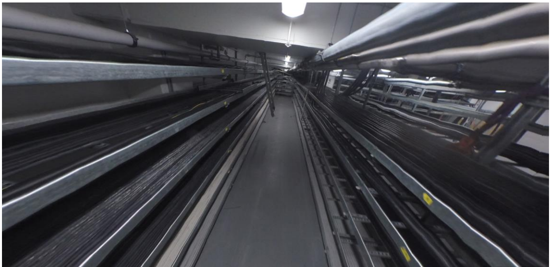
Kuva 31. 360°-kuva kaapelitilasta (Kallio, 2020)
