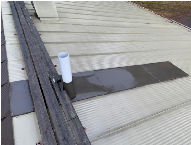
KUVA 13. G-talon katolta uusittu puolet lappeesta sekä osittain lisäpellitetty vanhaa puolta (Termonen 2020)
