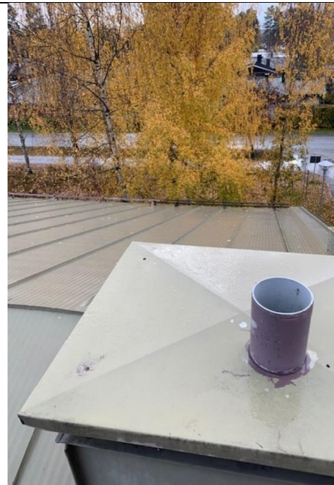
Kuva 43. Vesikaton pellitykset ovat pääosin hyväkuntoisia (Termonen 2020 CC BY-SA)
