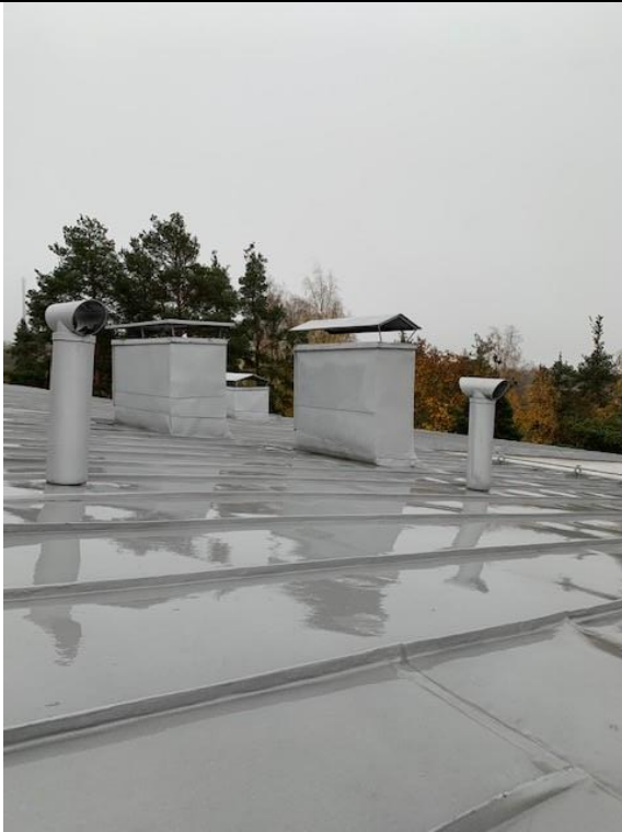
Kuva 85. Pinnoitettu hyväkuntoinen konesaumakatto (Termonen 2020 CC BY-SA)
