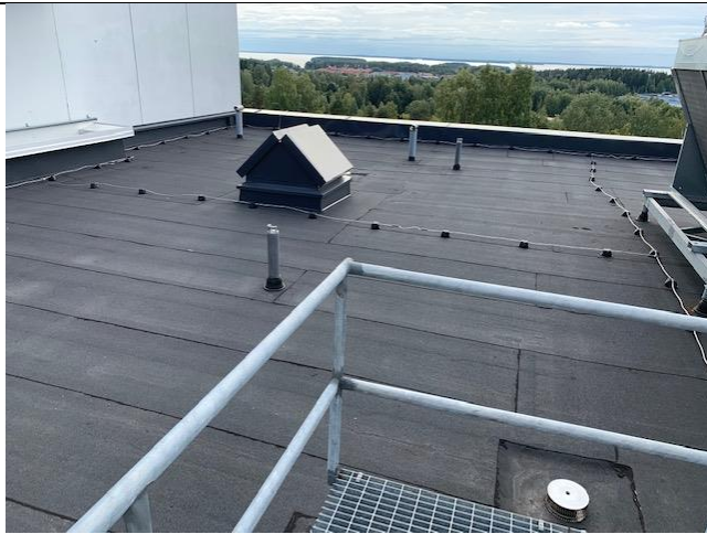
Kuva 47. J2/J1-rajapinnan alueella tehty tiivistyskorjauksia havaittujen vuotojen jälkeen kesällä 2020 (Termonen 2020 CC BY-SA)
