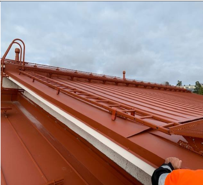
Kuva 27. Uusitut kattoturvatuotteet F-siivellä (Termonen 2020 CC BY-SA)
