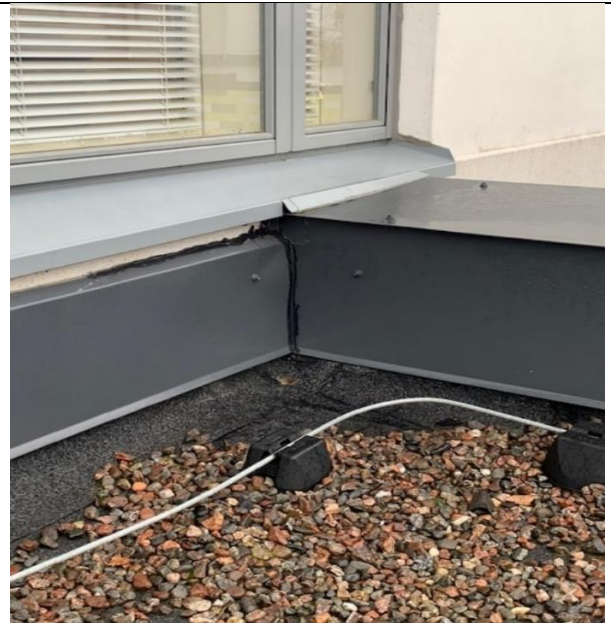
Kuva 56. L-talossa tiivistyskorjattu pellitys (Termonen 2020 CC BY-SA)
