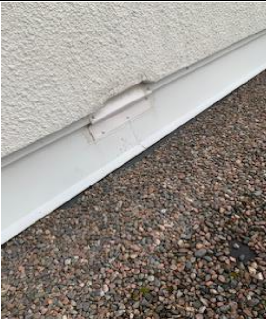
Kuva 42. Vesikaton pellityksiin tehty paikkaus (Termonen 2020 CC BY-SA)
