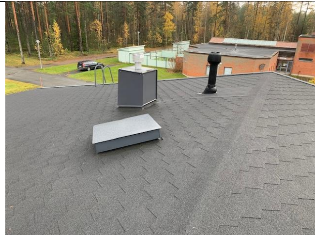
Kuva 30. Läpiviennit toteutettu asianmukaisesti (Termonen 2020 CC BY-SA)
