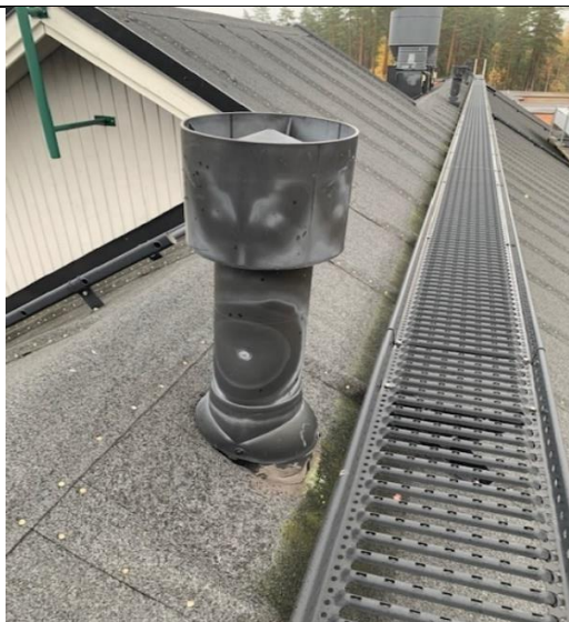
Kuva 52. Läpivientien tiivisteissä ei havaittuja puutteita (Termonen 2020 CC BY-SA)
