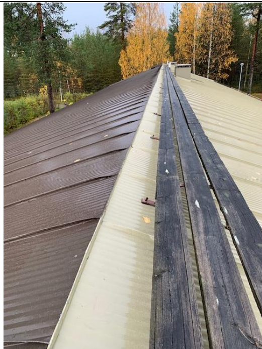
Kuva 27. Toinen lape uusittu 2014 tulipalon aiheuttamien vaurioiden takia (Termonen 2020 CC BY-SA)
