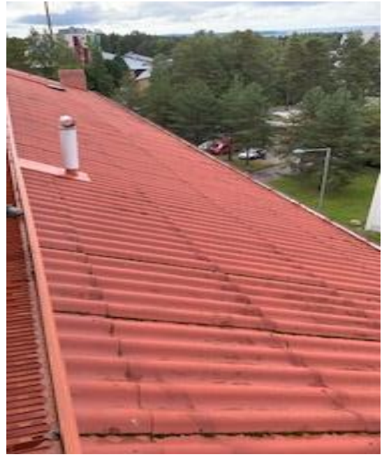
Kuva 7. Varttikatteen kunto ja läpiviennin uusittu pellitys (Termonen 2020 CC BY-SA)
