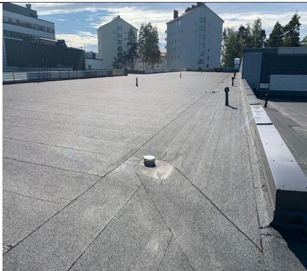
Kuva 72. Yleiskuva vesikatosta havainnollistamaan kuntoa (Termonen 2020 CC BY-SA)
