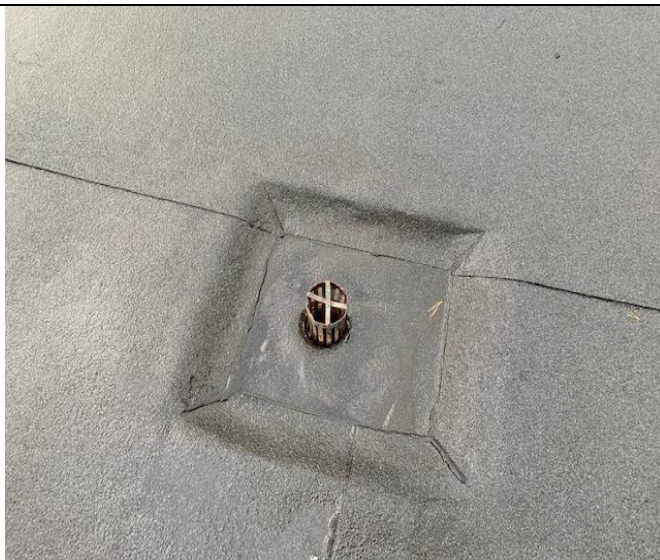
Kuva 17. Kattokaivojen puhtaus tarkastettu (Termonen 2020 CC BY-SA)
