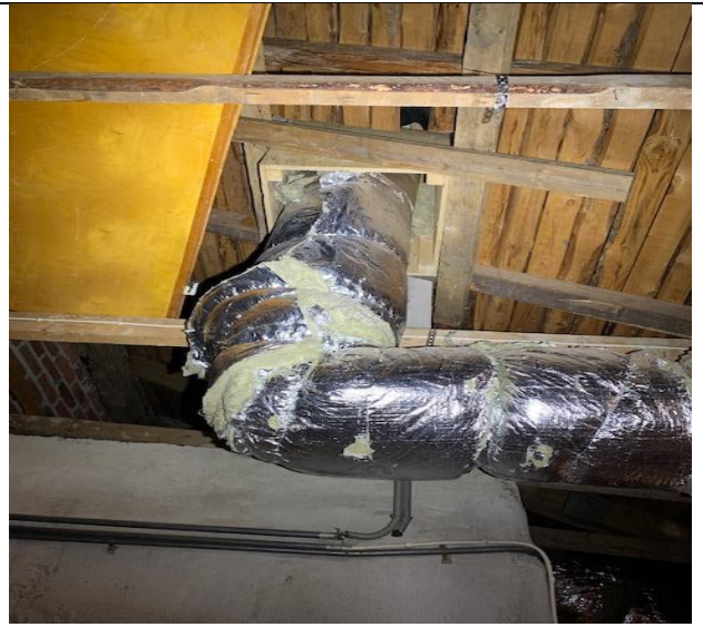
Kuva 76. Läpivienti kattopohjan puolelta, ei havaittuja vuotokoh-tia (Termonen 2020 CC BY-SA)
