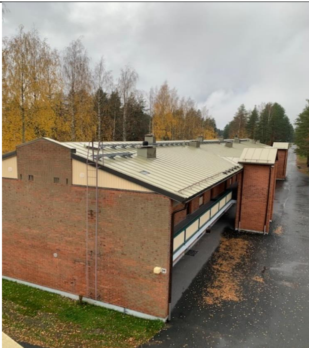
Kuva 42. M-talon vesikaton yleiskuva havainnollistamaan rakennetta (Termonen 2020 CC BY-SA)
