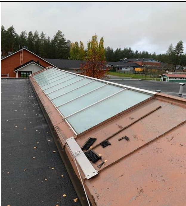
Kuva 37. Vesikaton savunpoistojärjestelmä ja kattoluukut toteutettu harjakattotyylillä (Termonen 2020 CC BY-SA)
