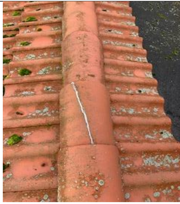
Kuva 18. Haljenneen tiilen paikkaus tiivistemassalla (Termonen 2020 CC BY-SA)
