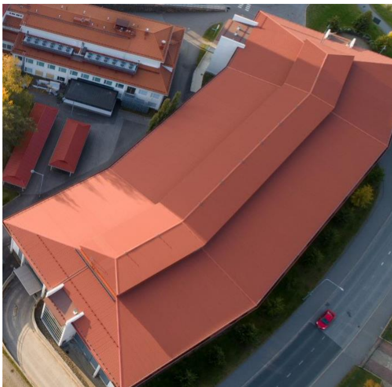
KUVA 6. Pysäköintihalli P1 ja D-talon vesikatot ovat aumakattorakenteisia (Siun sote 2020)
