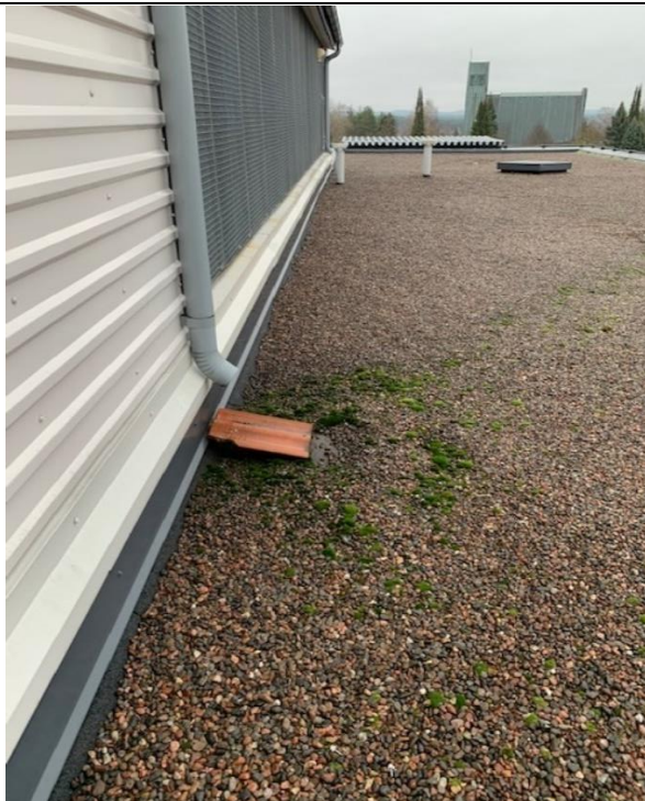
Kuva 52. Sadevesien ohjausta tehostettava tasakatto osuuskilla (Termonen 2020 CC BY-SA)
