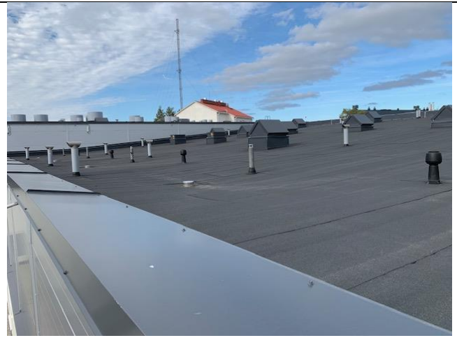
Kuva 48. 70 kpl läpiviennit ja pellitykset tarkastettu silmämääräisesti (Termonen 2020 CC BY-SA)
