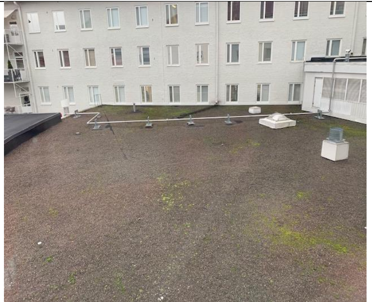
Kuva 38. H-siipi vesikatto kokonaisuudessaan (Termonen 2020 CC BY-SA)
