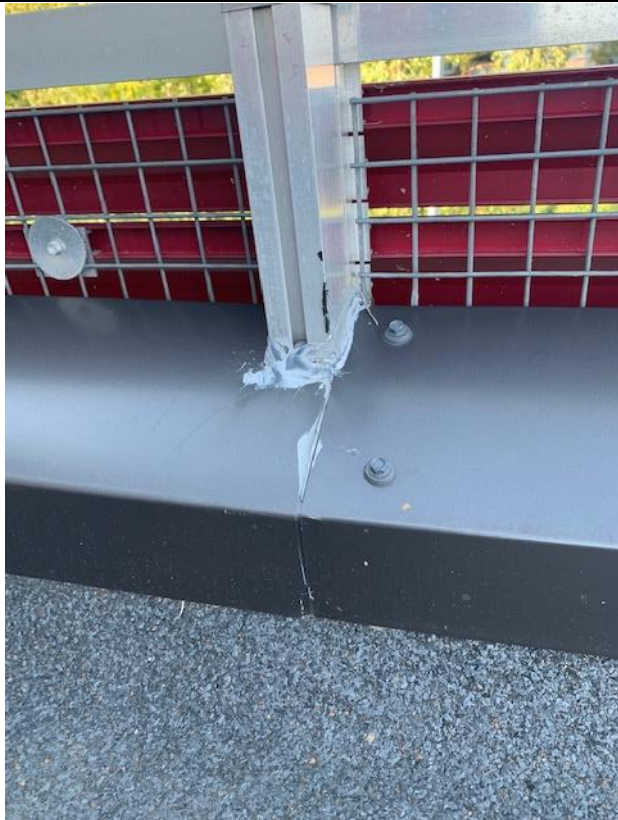
Kuva 70. Pellityksien läpi viedyt julkisivurakenteet tiivistetty massalla tiiviiksi (Termonen 2020 CC BY-SA)
