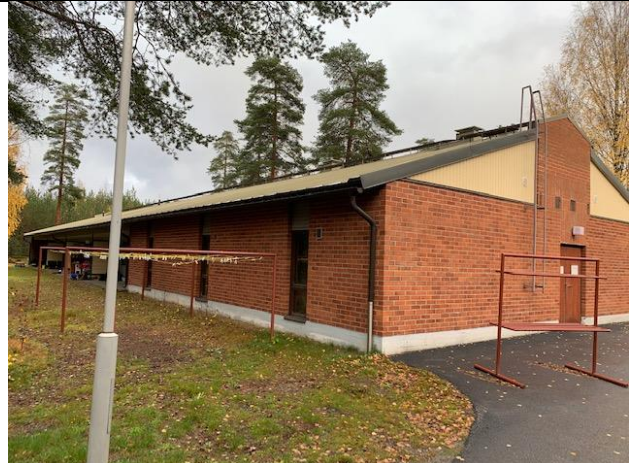
Kuva 21. Yleiskuva F-talosta ja syöksytorvista (Termonen 2020 CC BY-SA)
