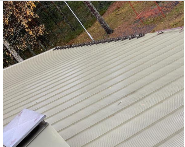
Kuva 26. Lumiesteet uusittu katteelle osittain (Termonen 2020 CC BY-SA)
