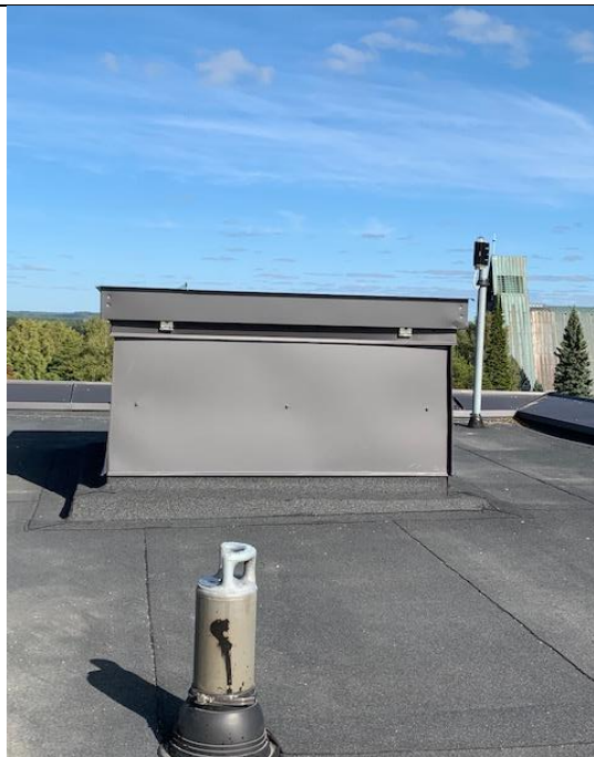
Kuva 62. M-talon pellityksissä, reunanostoissa tai läpiviennin tiivisteissä ei havaittuja vuotokohtia (Termonen 2020 CC BY-SA)
