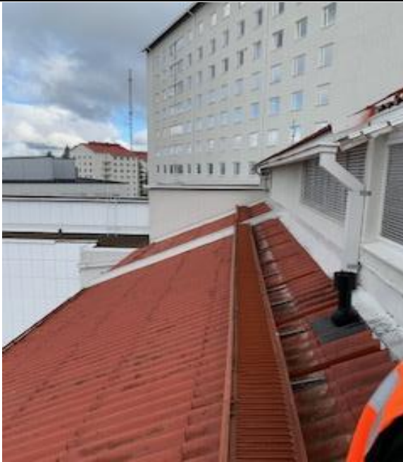
Kuva 8. Vesikatto ja kävelysilta B-rakennuksessa (Termonen 2020 CC BY-SA)
