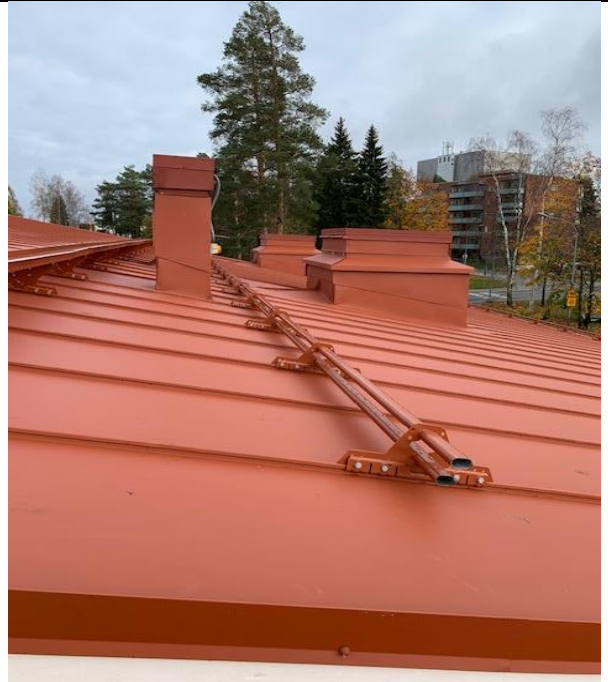
Kuva 26. F-siipi uusitut savunpoistoluukkujen pellitykset (Termonen 2020 CC BY-SA)
