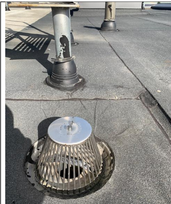
Kuva 60. M-talon kattokaivojen puhtaus tarkastettu (Termonen 2020 CC BY-SA)
