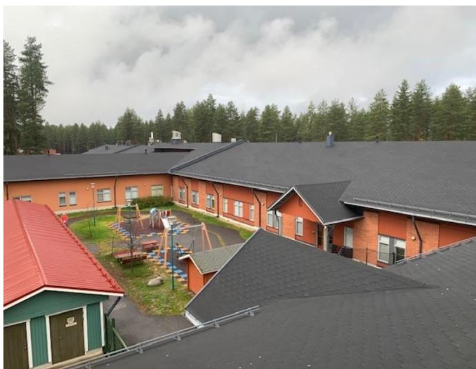
KUVA 15. A-talon bitumikermikate (Termonen 2020)
