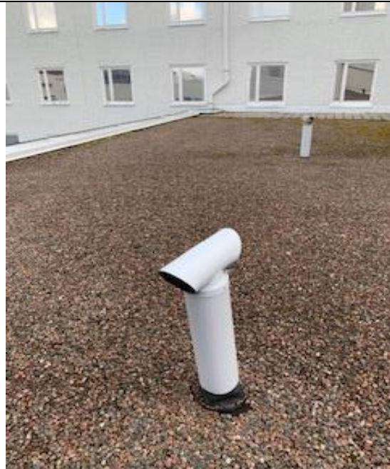
Kuva 43. Tuuletuskanavien tiivistykset tarkastettu (Termonen 2020 CC BY-SA)
