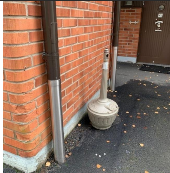
Kuva 41. Etupihan sadevedet ohjautuvat suoraan kaivoihin, mikä vaikeuttaa huoltotoimenpiteiden tekoa kuten puhdistusta (Termonen 2020 CC BY-SA)
