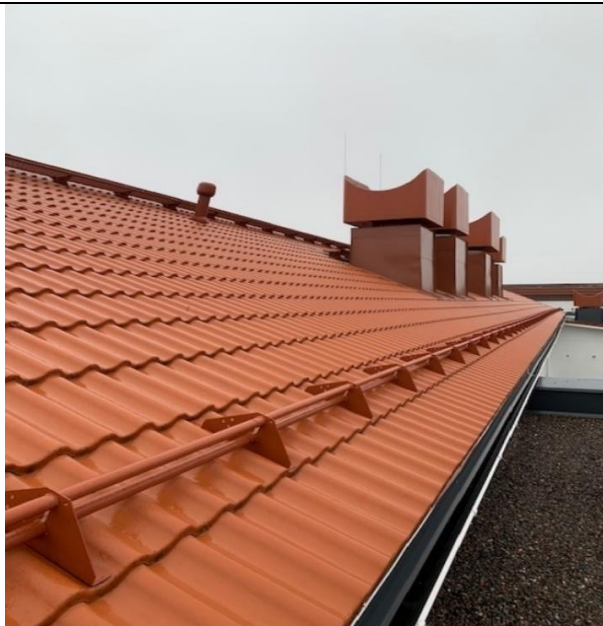
Kuva 57. Tiilikatteet hyväkuntoisia koko rakennuksessa (Termonen 2020 CC BY-SA)
