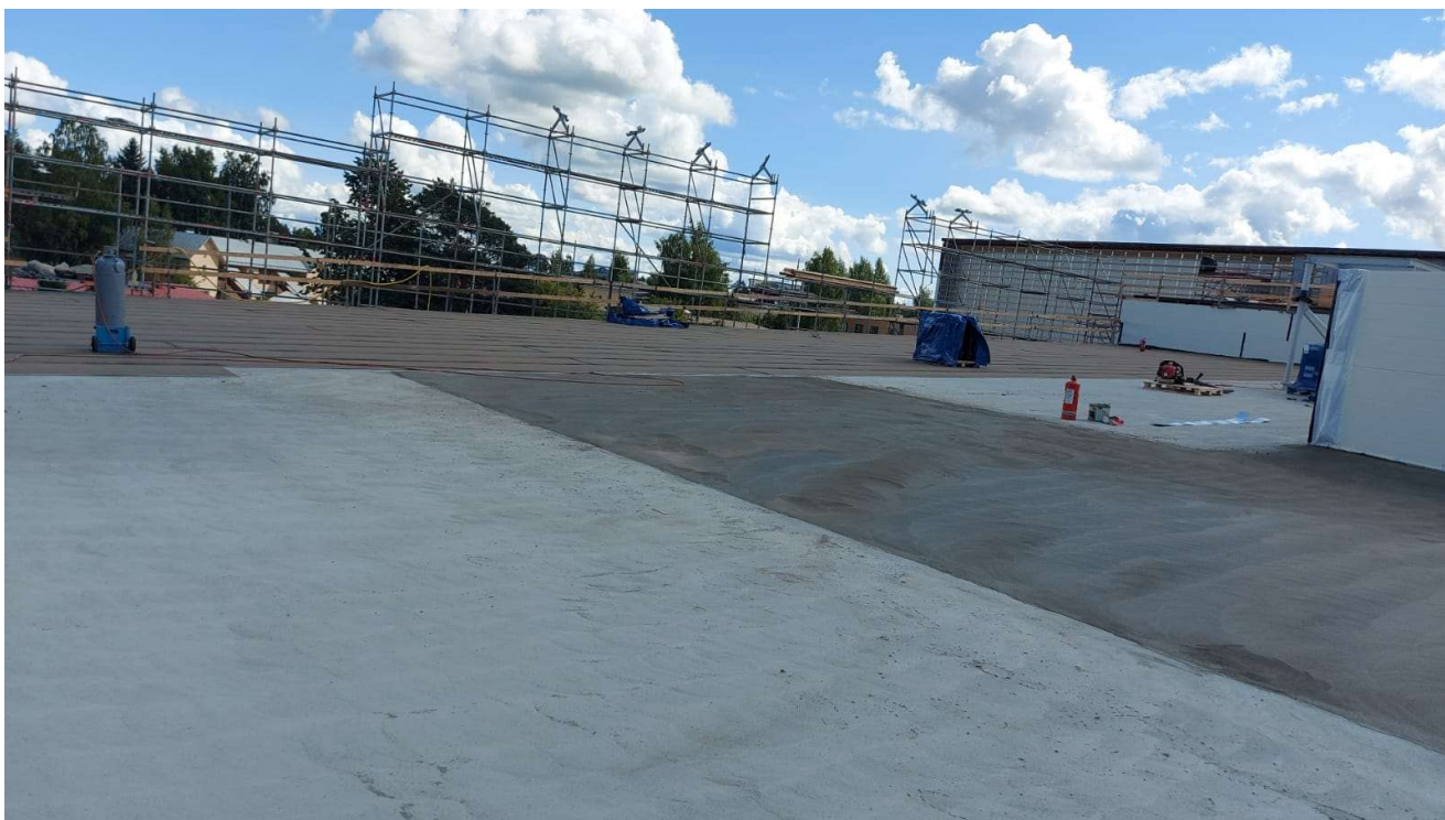
KUVA 3. Uudiskohteen höyrynsulun asennusvaihe (Janhunen 2020, CC BY-ND)
