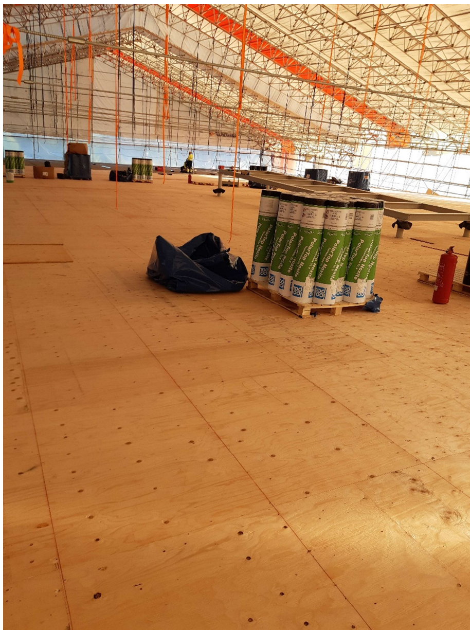
KUVA 1. Uudiskohteen vesikaton vedeneristys (Janhunen 2020, CC BY-ND)
