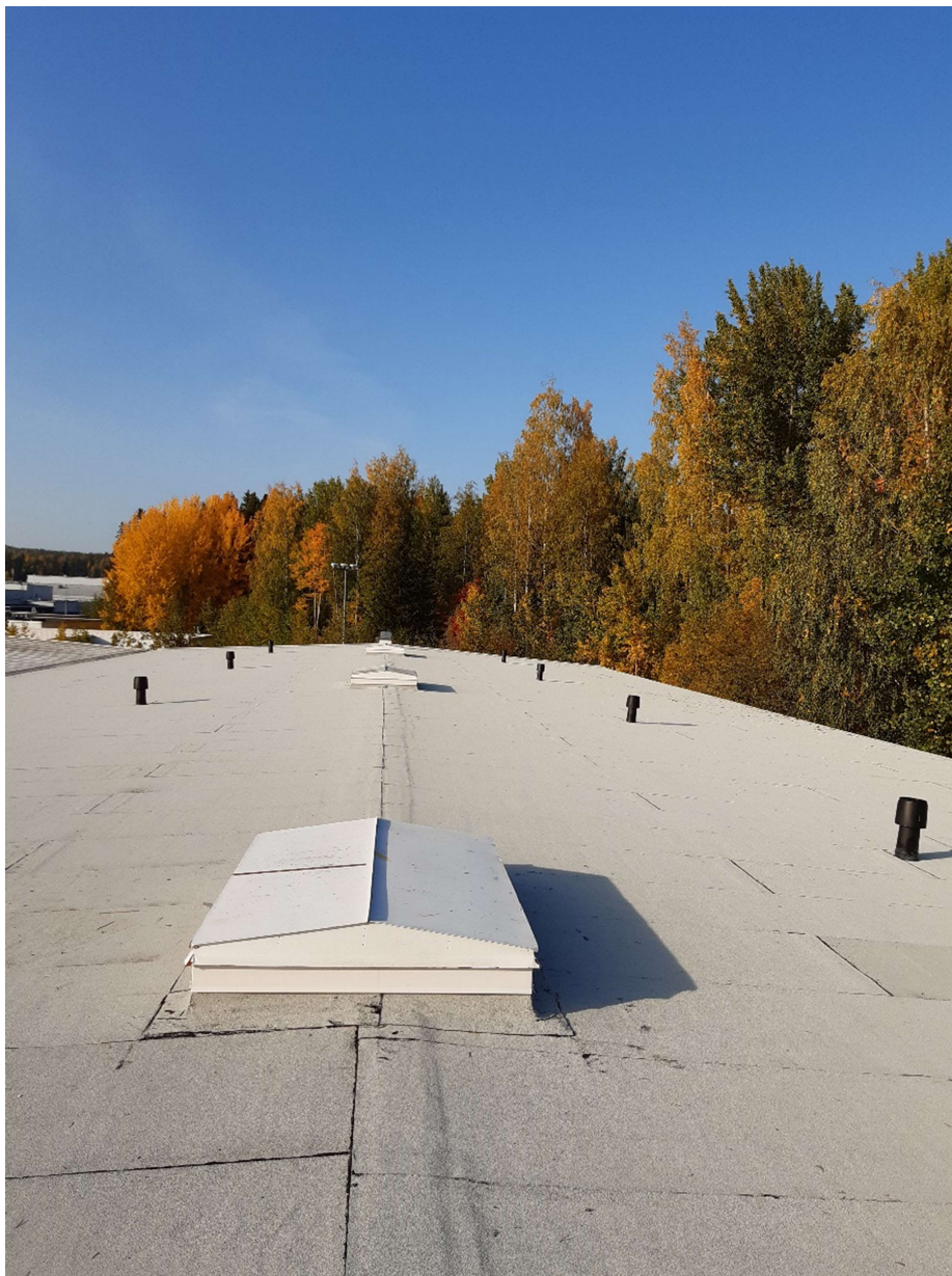
KUVA 4. Saneerauskohde, jossa peltikatto muutettu kermikatoksi (Janhunen 2020, CC BY-ND)
