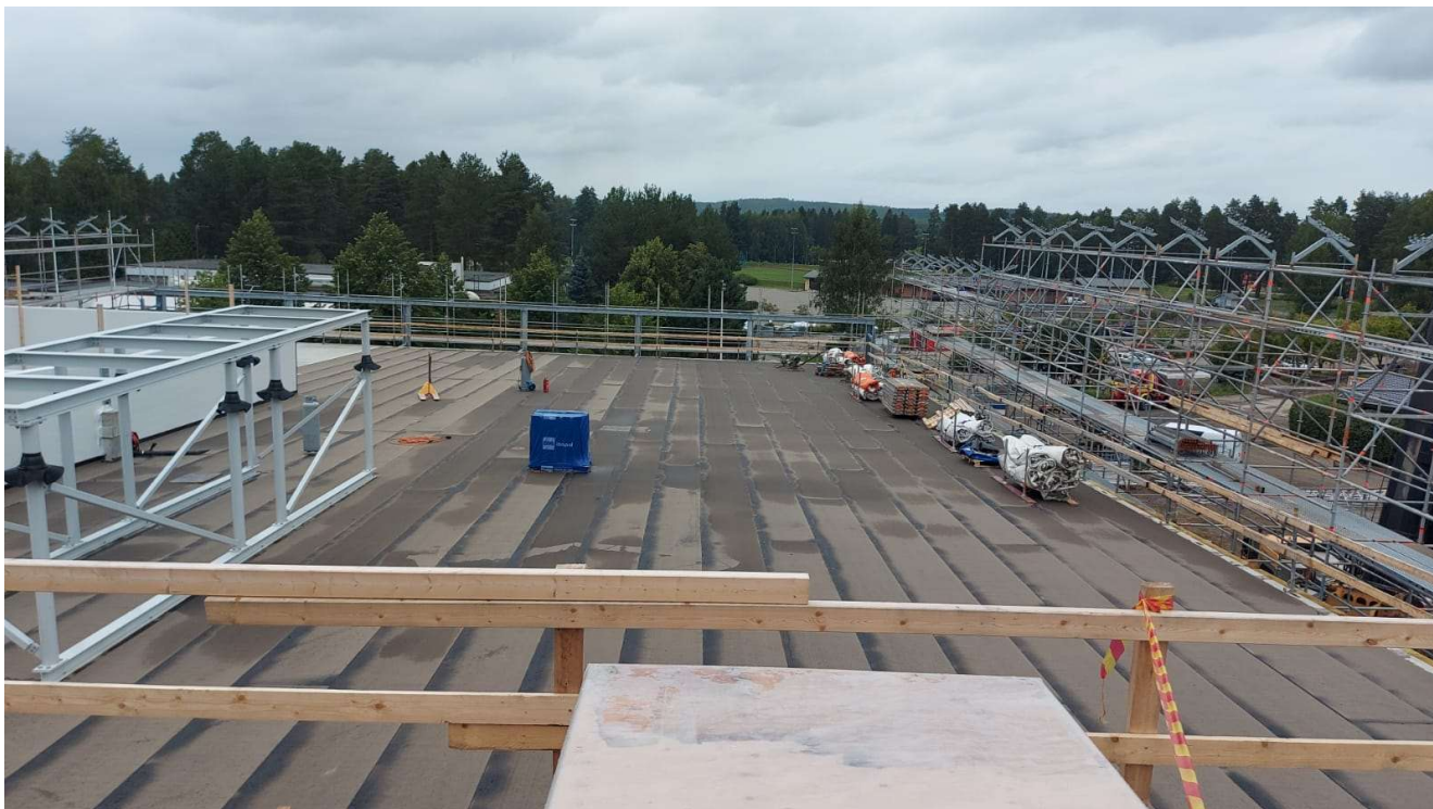
KUVA 2. Uudiskohteen höyrynsulun asennusvaihe (Janhunen 2020, CC BY-ND)
