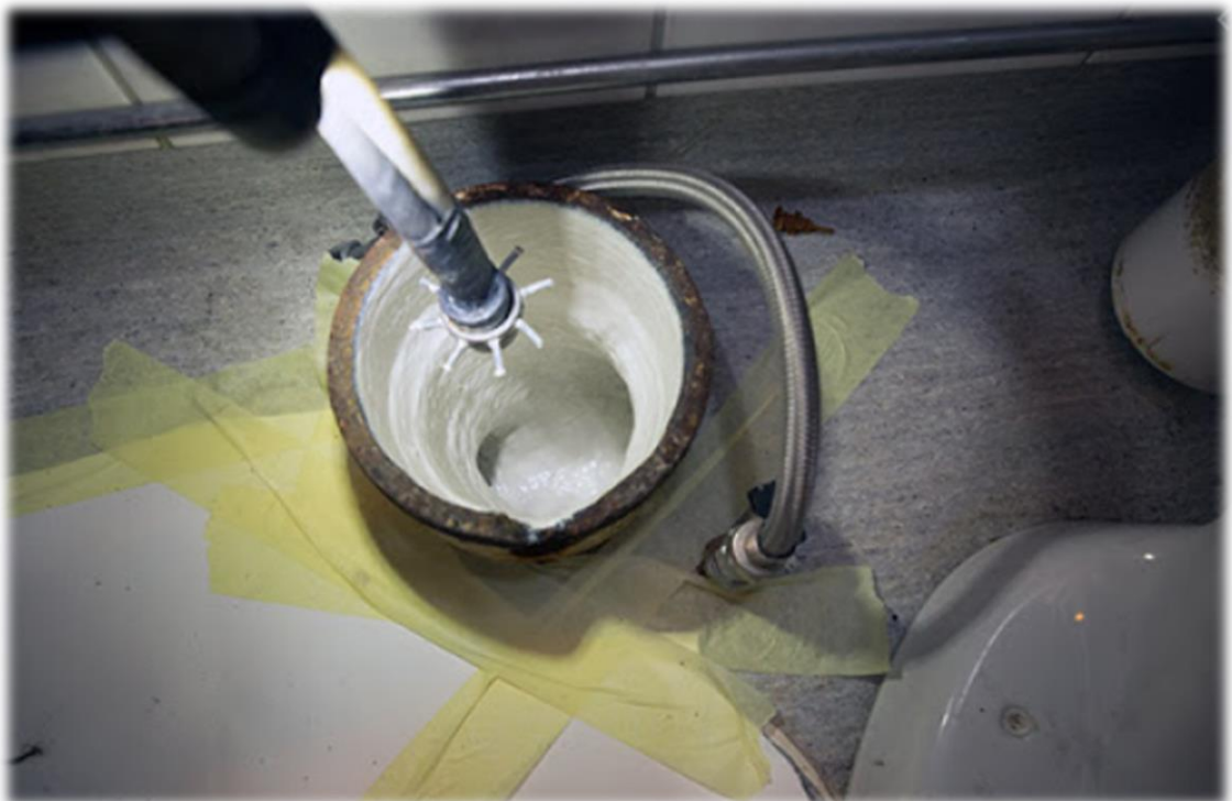
Kuva 6. Viemäriin pinnoitus ruiskuvalamalla (Relino Pipe Oy Ab.)
