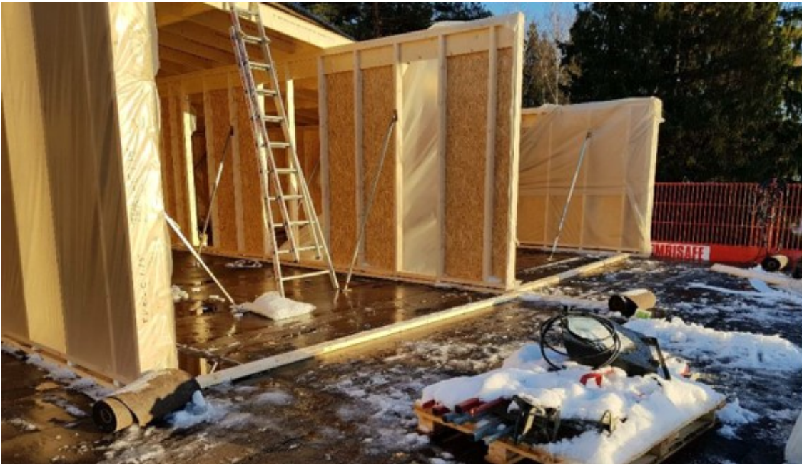
Kuva 10 Vesikaton puurakenne. (Sweco, sisäinen arkisto, henkilökohtainen tiedonanto)
