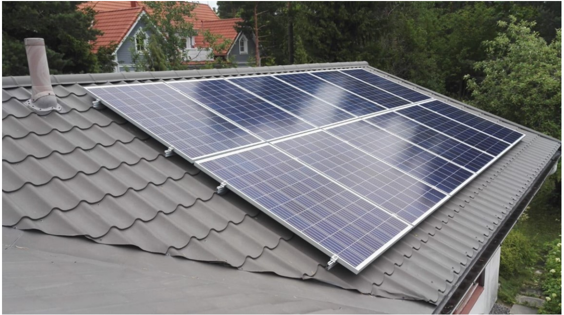
Kuvio 6. JA-Solarin monikidepaneelisto katolle asennettuna.
