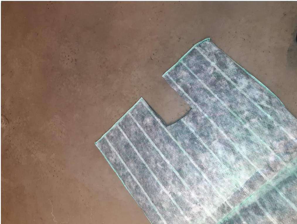
KUVA 5. Materiaalinäytteet otettiin pussisuodattimen pussin pohjalta
