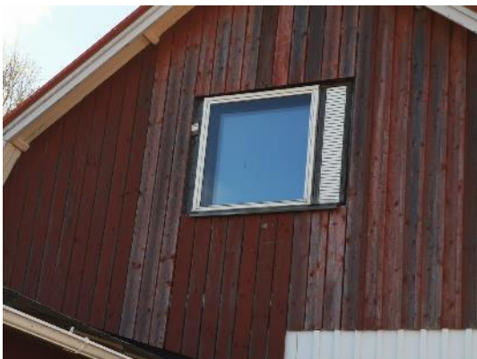
Figur 24 Fönster 7 på östra sidan.
