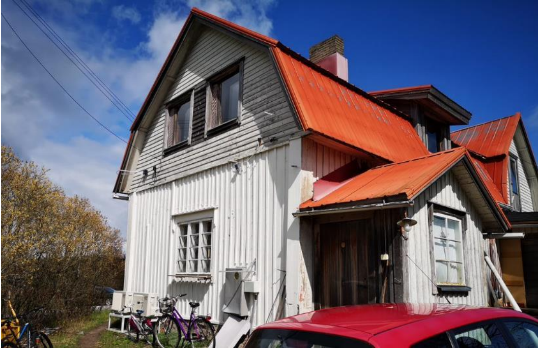
Bild 30 Västra sidan av huset, här ser man fönster 13-15 och dörr 5.
