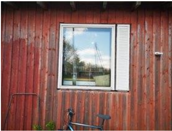
Figur 27 Fönster 9 på södra sidan.
