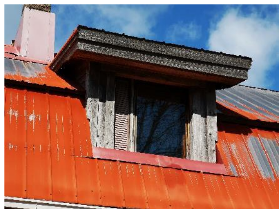
Figur 28 Fönster 12 på södra sidan.
