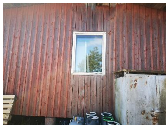
Figur 25 Fönster 8 på östra sidan.
