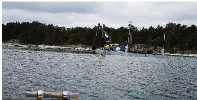
Figur 8. Grävmaskin på pråm
