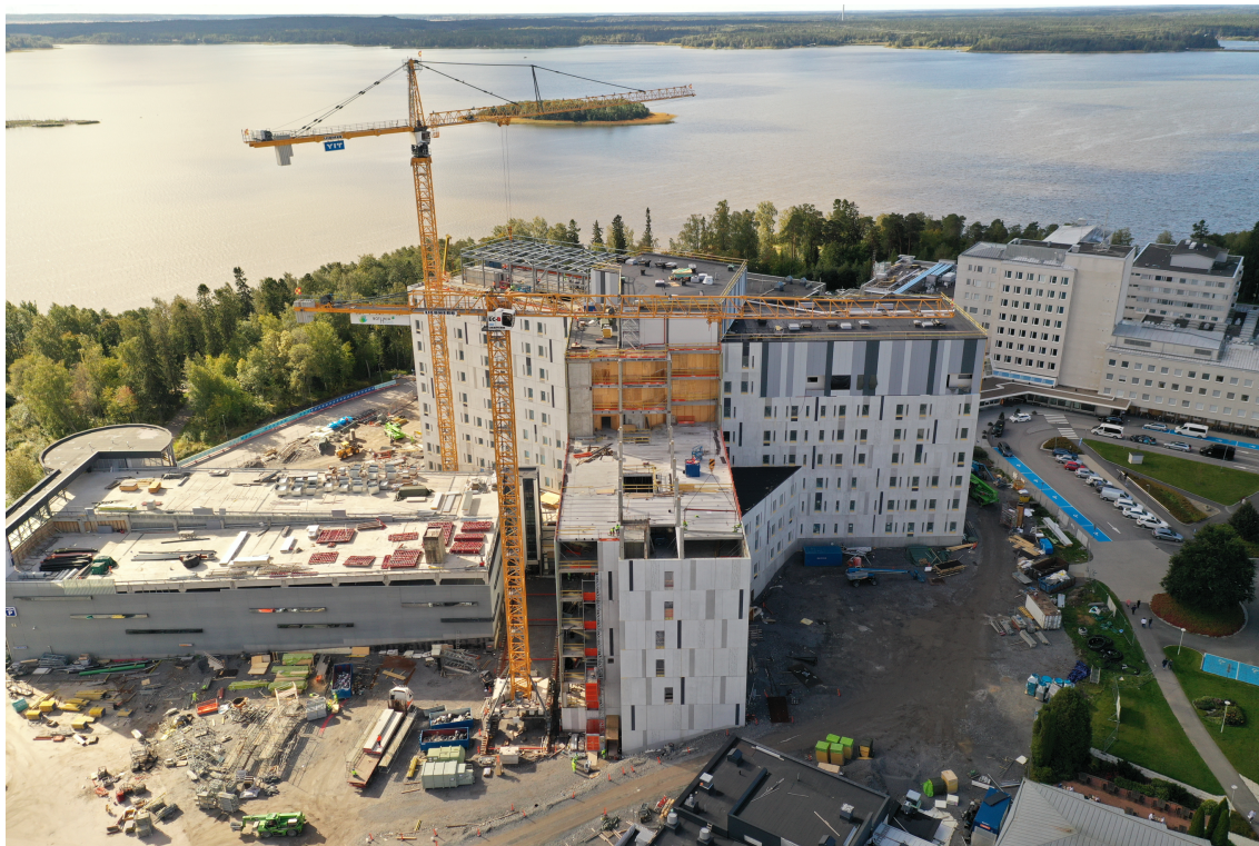
Kuva 4. Vaasan keskussairaalan alueen H-rakennuksen työmaa (Kuva: Bothnia High 5 -allianssin kuvapankki).
