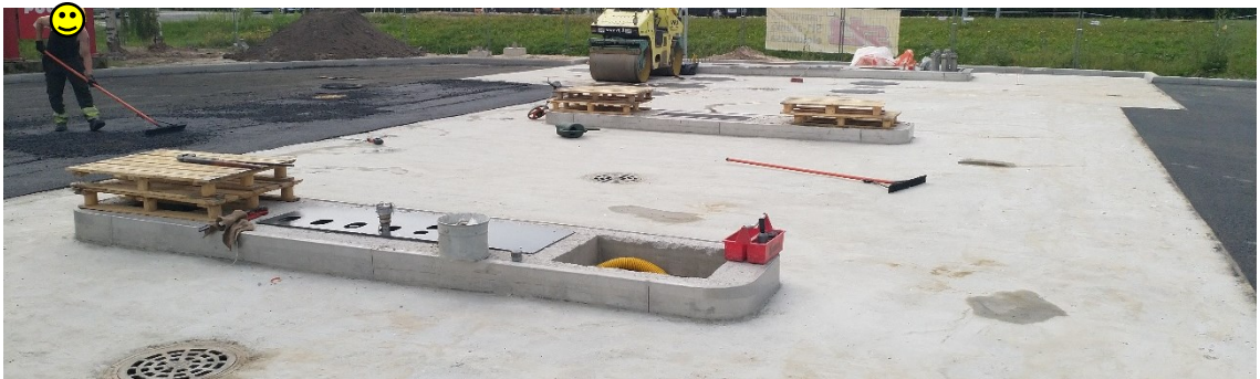
Kuva 8. Pintalaatta valettuna ja asvaltointi käynnissä.
