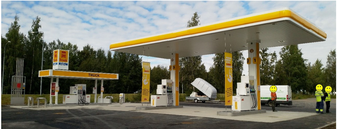
Kuva 10. Valmis polttoaineen jakeluasema odottamassa avaamista. Katoksista poistettu asiakkaan logot.
