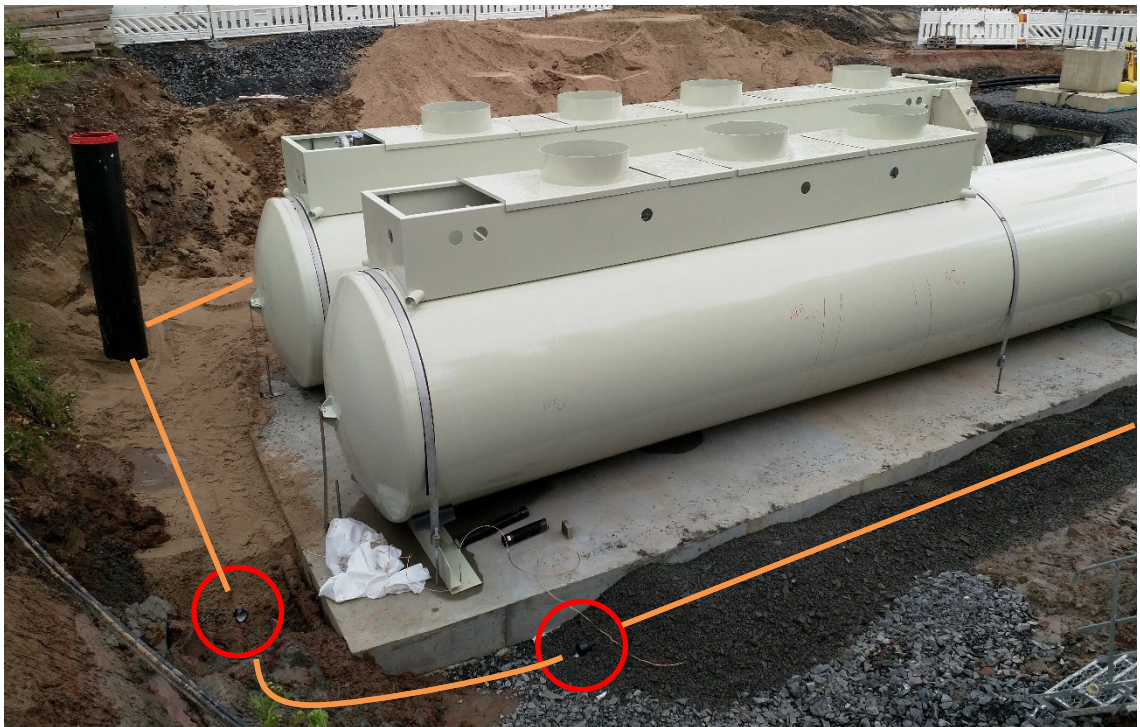
Kuva 1. 60m 3 säiliökontit ankkuroituina laatalle. Vasemmalla tarkkailukaivo. Oikeassa yläkulmassa pilarin "tattiperustus". Ympyröitynä tarkkailuputken päät. Oranssi viiva kuvaa tarkkailuputken kuvassa näkymättömiä osia.
