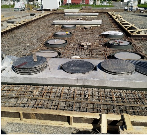
Kuva 7. Pintalaatan raudoitus ja valumuotti, saarekkeet ja huoltoluukut.
