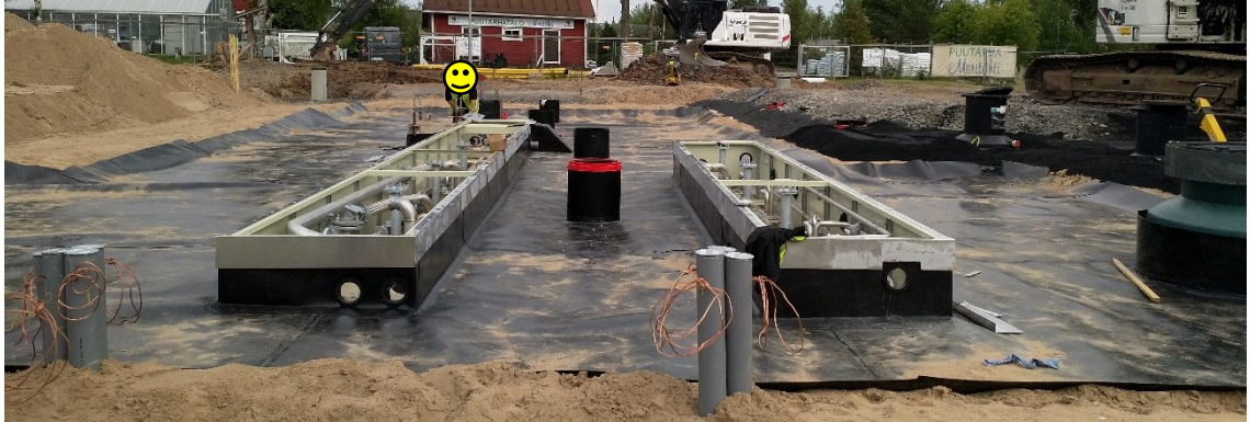
Kuva 4. HDPE-kalvo asennettuna. Kuvassa etualalla huokosilmaputkien päät.
