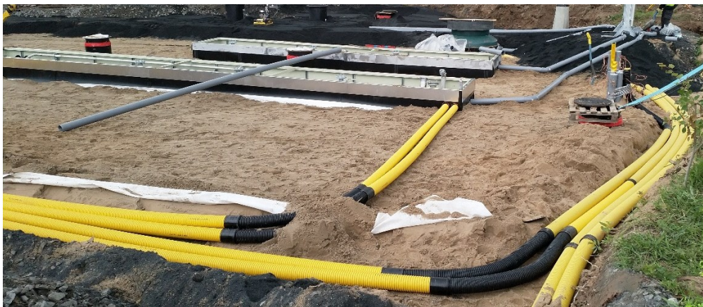
Kuva 5. Huoltokuiluille ja aluevalaistukselle vedettyjä sähköputkia. Oikeassa yläkulmassa kuilujen tuuletusputkia ilmaputkipatterille.
