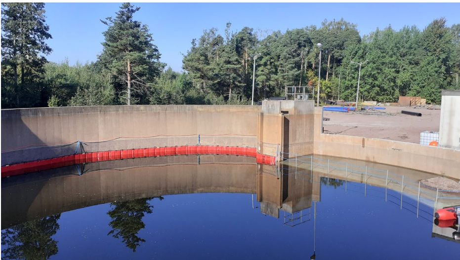
Kuva 1. Betonialtaan suojaksi asennettu öljyntorjuntapuomi. (Kuva: A. Myrén 2020)
