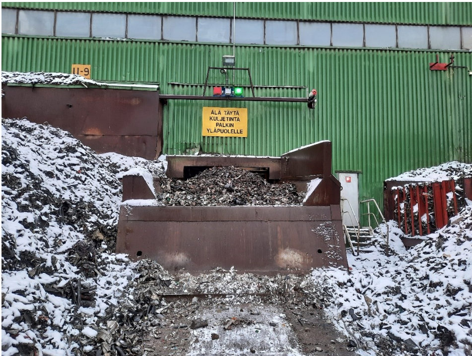
Kuva 3 Syöttölamelli ulkoapäin kuvattuna
