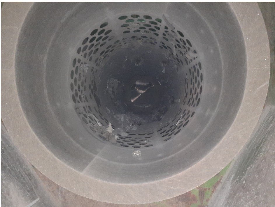
Kuva 4 Rumpuseula ylitepäästä kuvattuna
