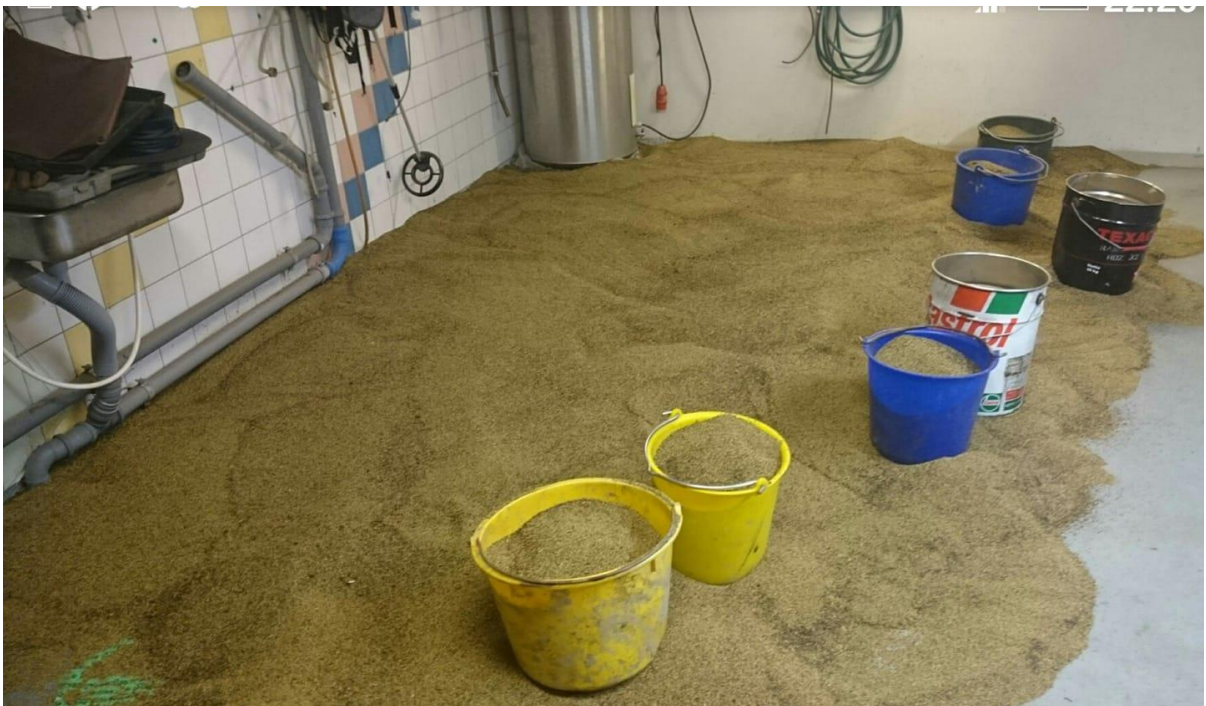
Kuva 17. Kuivaus entisen maituhuoneen lattialla. (Kuva: Antti Ritala)
