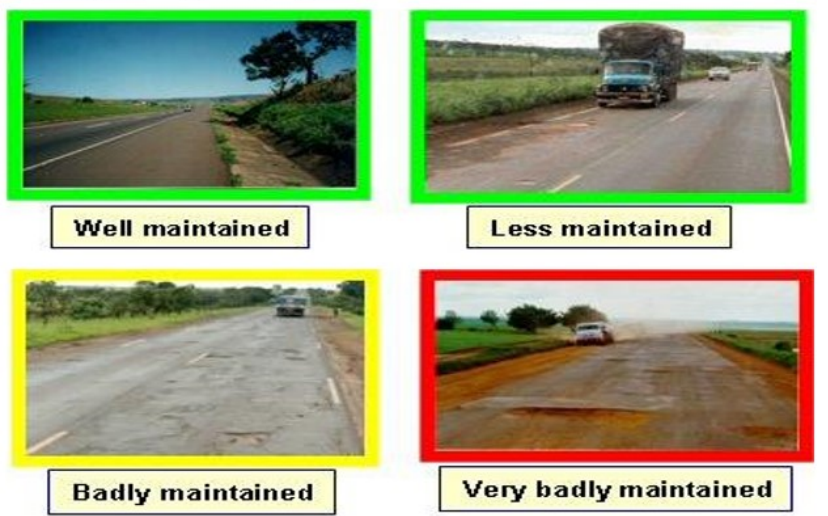
KUVA 14. Tiestön kunto (7, s. 132)
