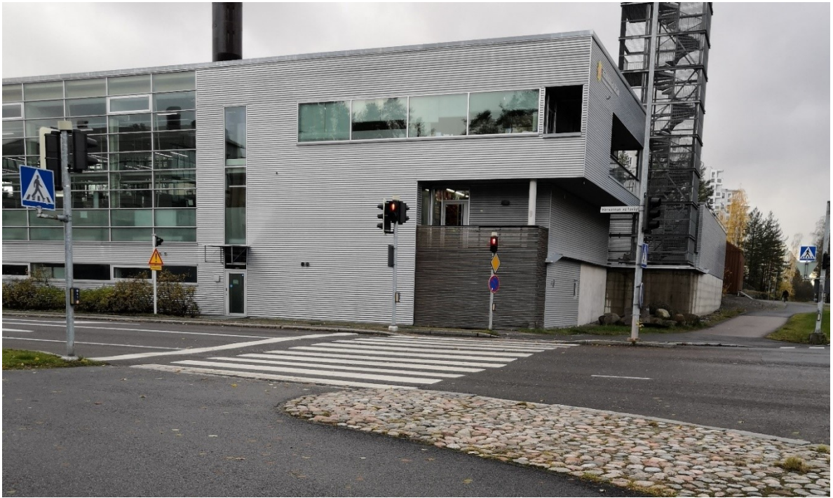
Kuva 6. Suojatie 1 Hervannan valtaväylällä.
