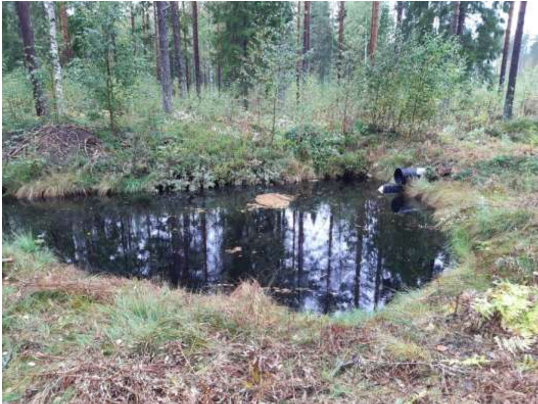
Kuvio 1. Esimerkki nykyisin yleisesti käytössä olevasta laskeutusaltaasta, jossa virtaamanhallinta on toteutettu putkipadolla.
