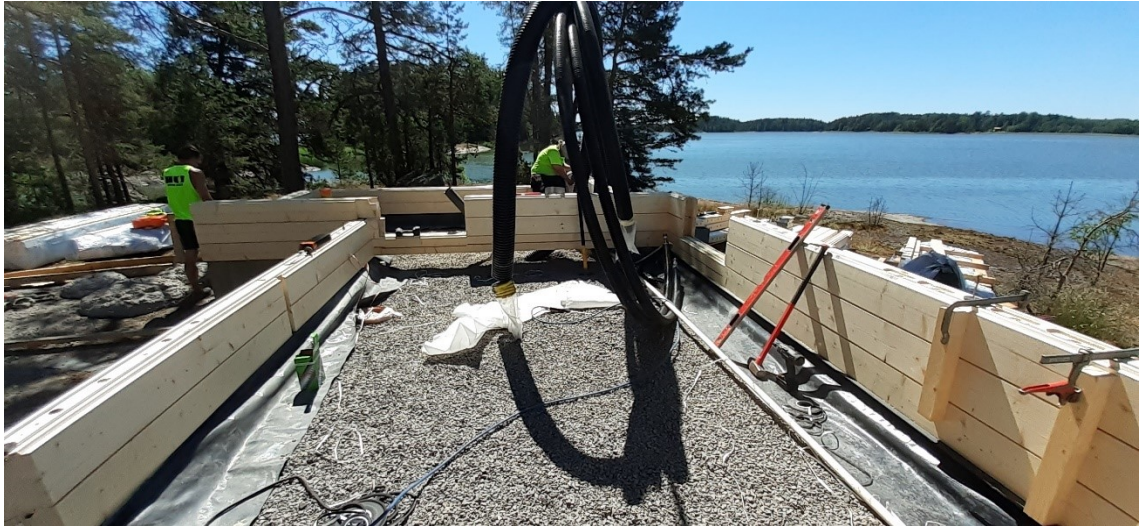
Kuva 6. Saunarakennuksen hirsikehikon kasausta.
