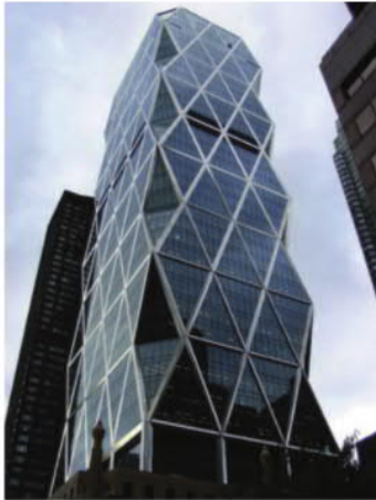
Kuva. 25. Hearst Headquarters, New York, Diagrid -system (Moon 2008, 897).
