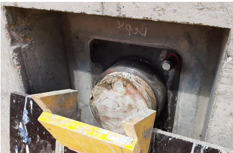
Kuva 162 Tartunnallinen ankkuri injektoituna. Ankkurikupin valumuotti odottaa asennusta.
