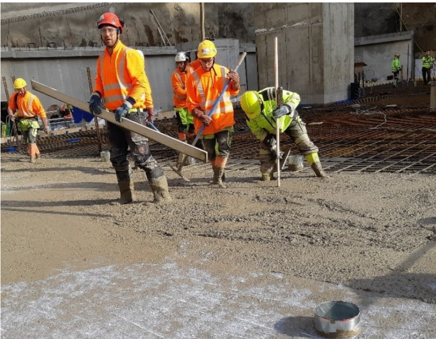
Kuva 144 Välihoitoaineen levitetään heti betonin tasoituksen jälkeen.
