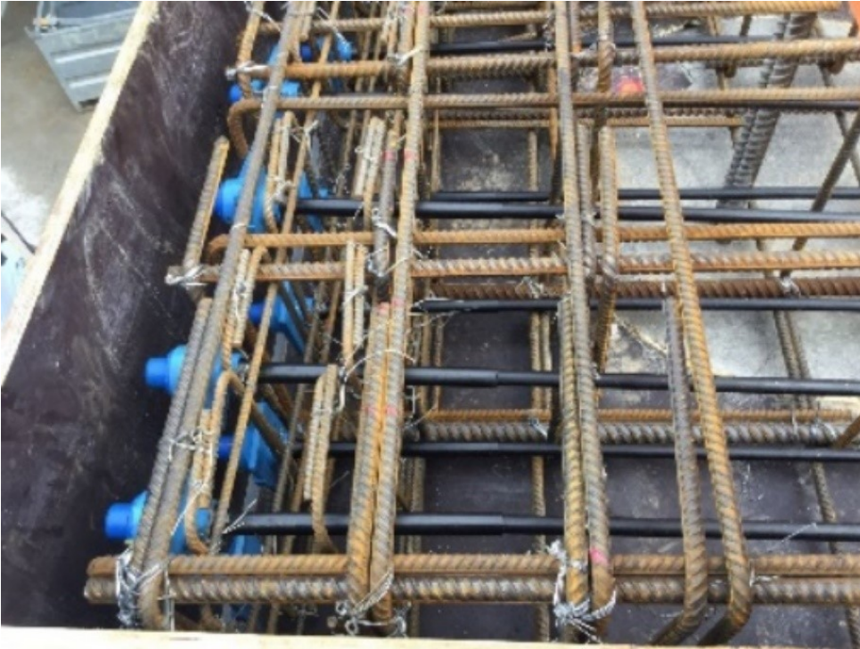
Kuva 115 Palkin päässä punokset kahdessa kerroksessa.
