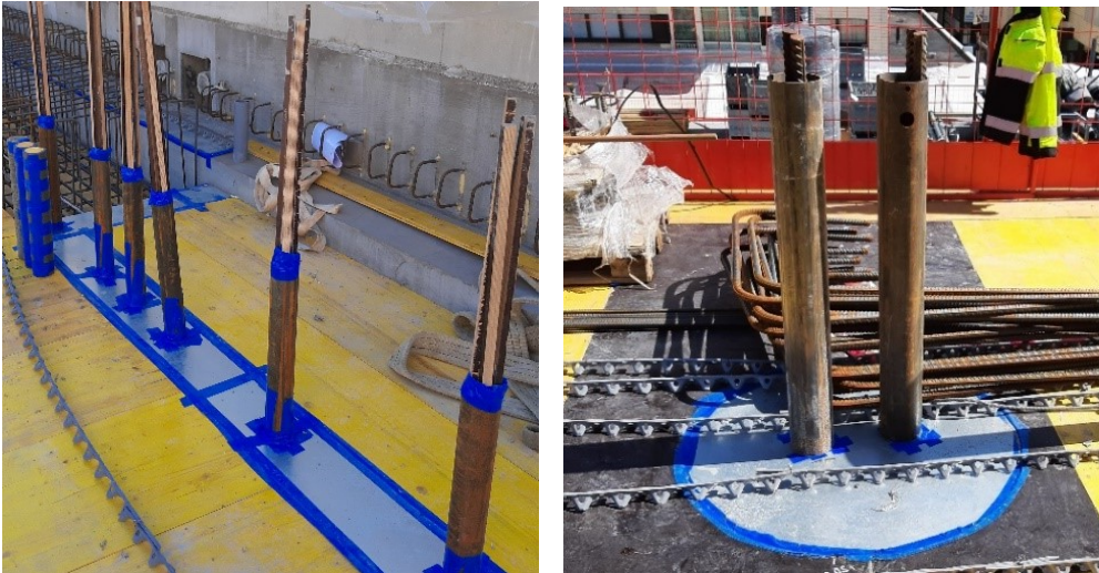
Kuvat 67-68 Irrotusputket seinän sekä pilarin tartuntateräksissä.
