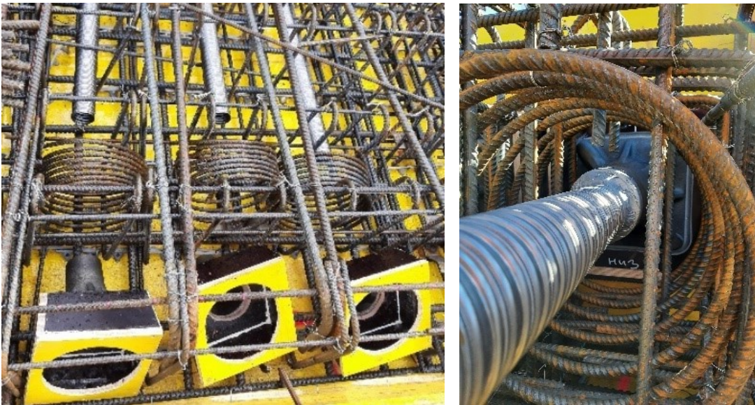
Kuvat 125-126 Suojaputkien päät tiivistetään ankkuriin.
