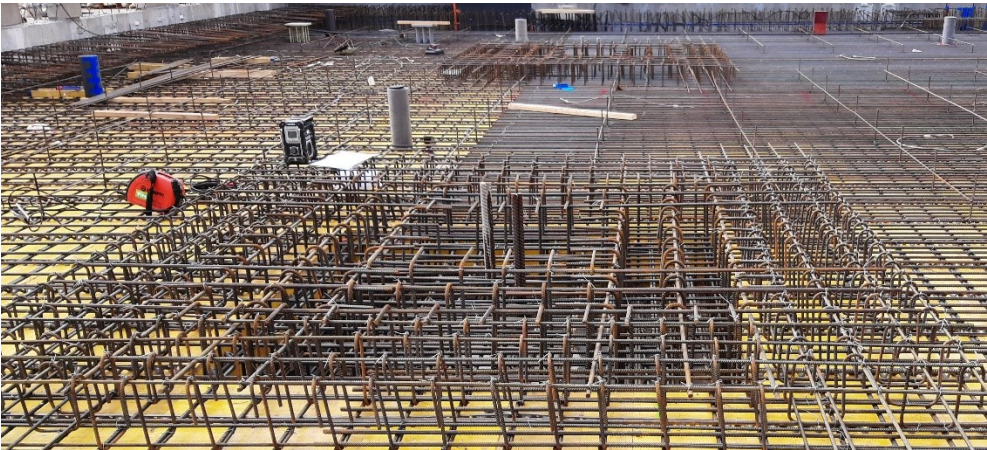
Kuva 86 Laatan alapinnan ja pilarivahvikkeen raudoitus.
