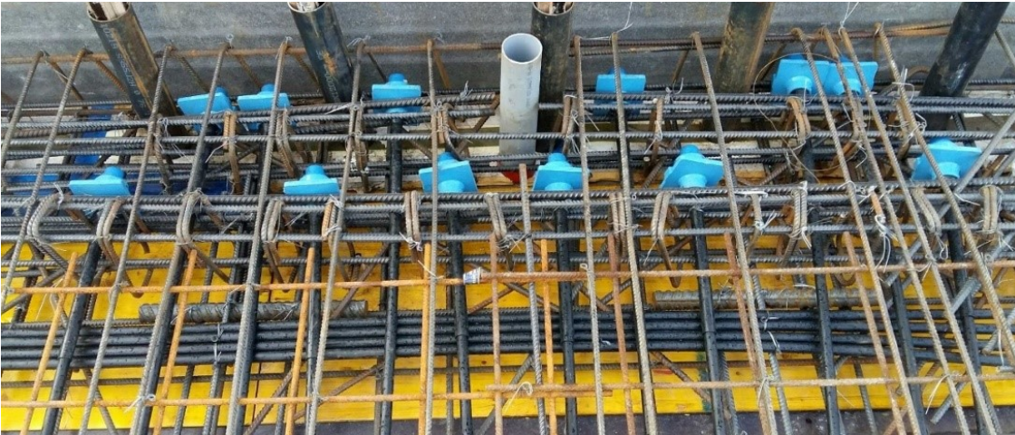
Kuva 120 Ankkureita siirretty syvyysuunnassa.
