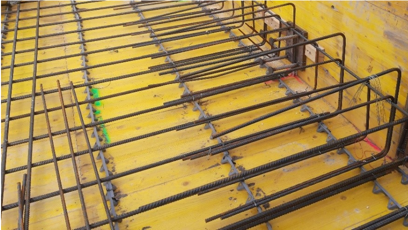
Kuva 94 Laatan raudoitus reunalla. Lisäksi reunassa myös korkeammat D-haak pihakannen kallistuksia varten.
