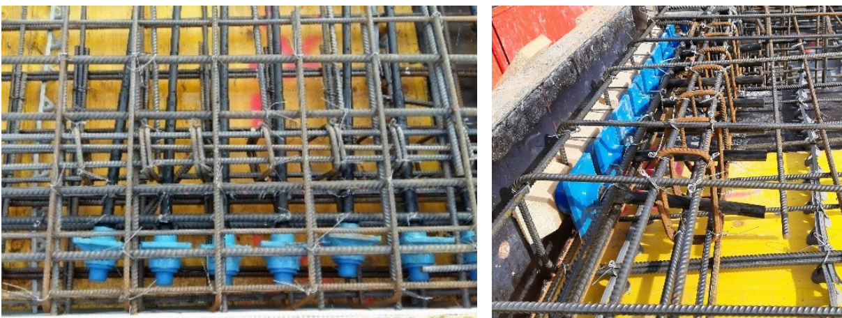
Kuvat 113-114 Tartunnattomien monoankkureiden raudoitus. Aktiivipää raudoitetaan ennen punosten asennusta.
