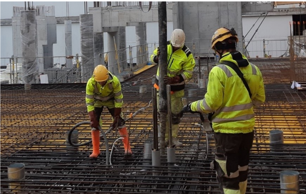
Kuva 142 Pilarivahvikkeen alueen betonointia.
