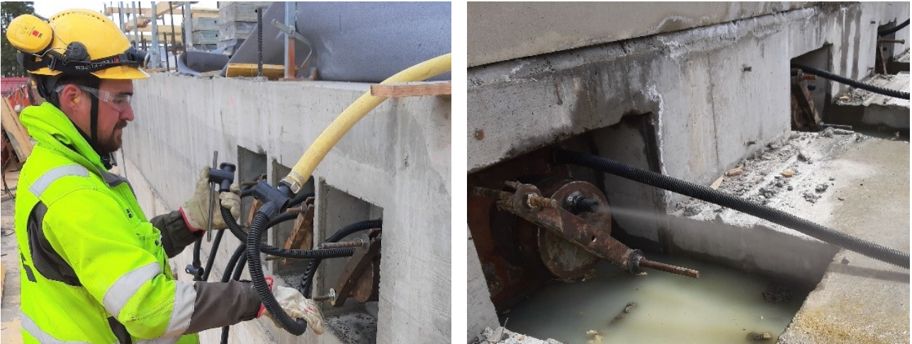
Kuvat 159-160 Suojaputket puhalletaan paineilmalla tyhjiksi.
