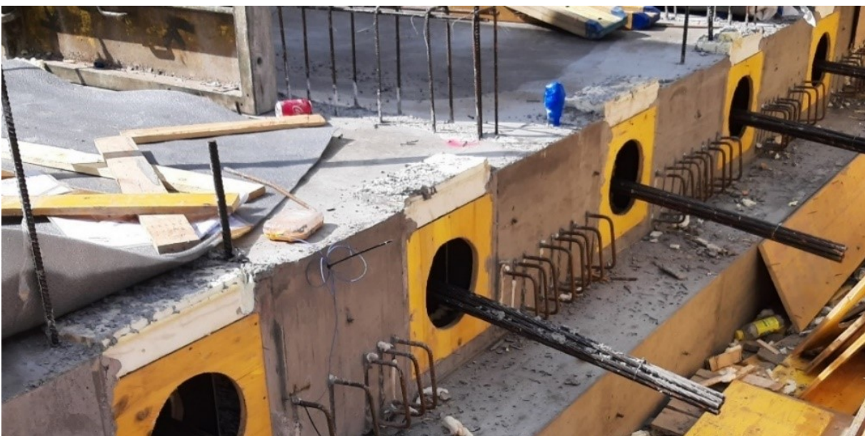
Kuva 147 Tartunnallisten jännerakenteiden muotti osittain purettuna.
