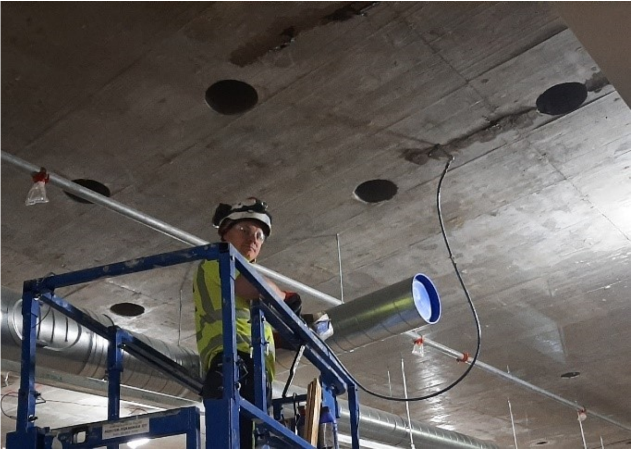
Kuva 169 Holvin halkeamien injektointia.
