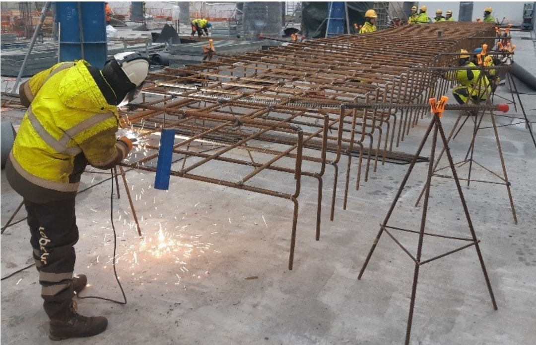
Kuva 84 Palkin rauditus käynnissä.
