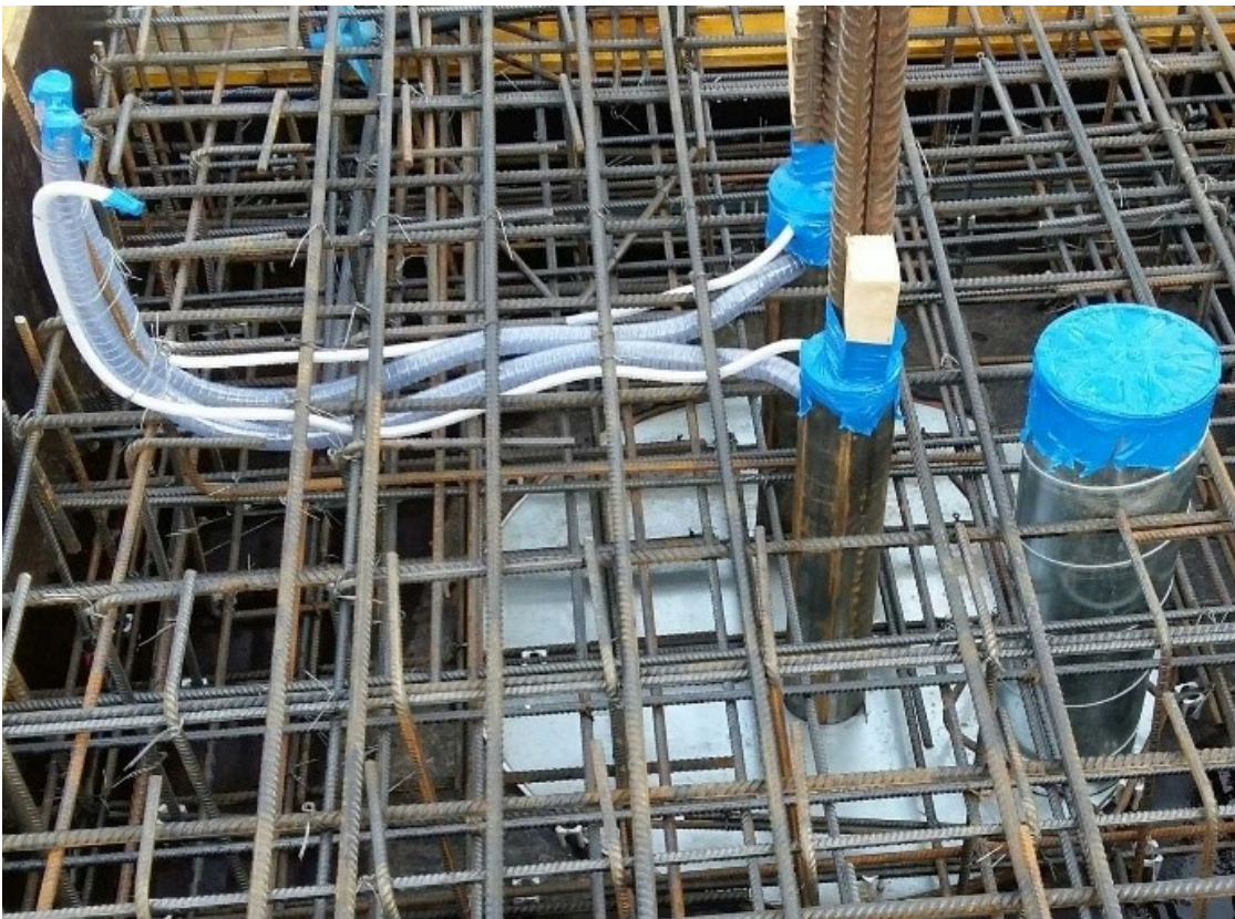
Kuva 136 Injektointiletkut ja ilmaletkut asennettuna pilarin irrotusputkiin.
