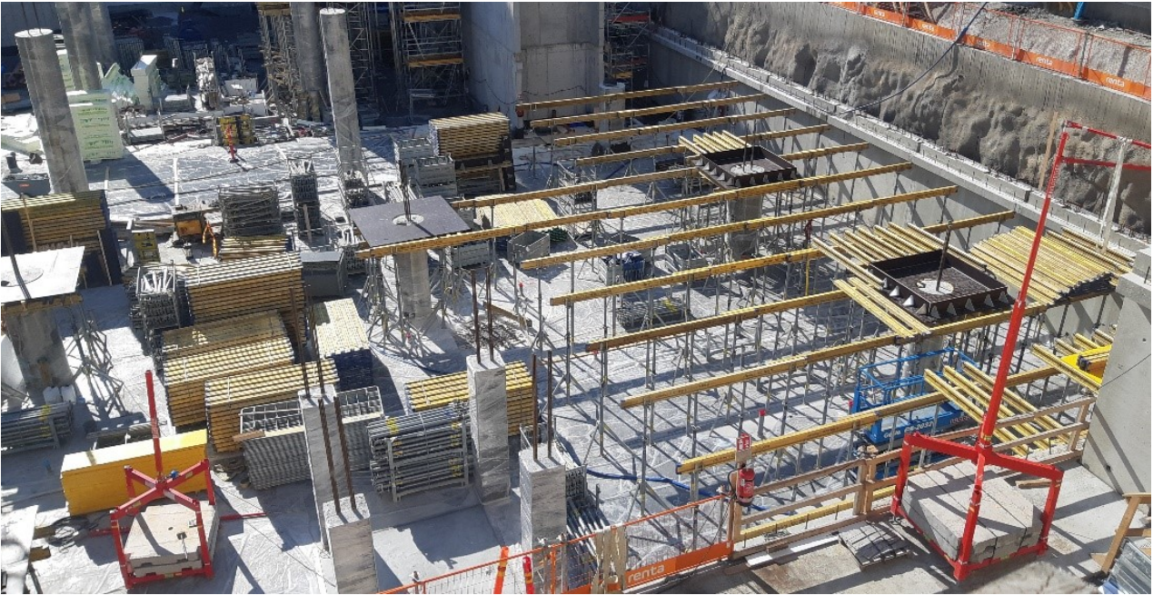
Kuva 42 Holvimuottityö alkaa maanvaraisen laatan päältä.
