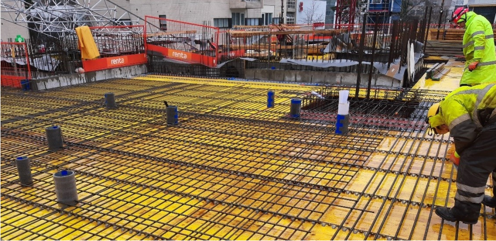
Kuva 85 Laatan alapinnan raudoitus.
