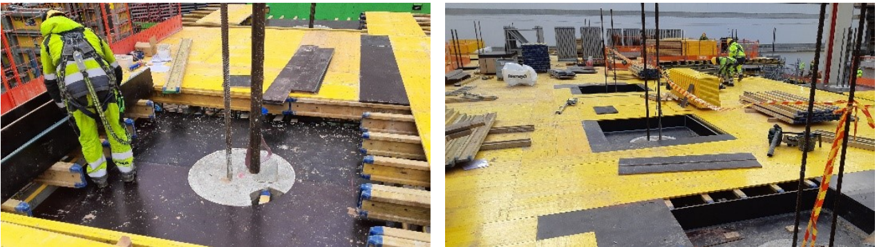
Kuvat 43-44 Pilarivahvennoksen muottirakenteita.
