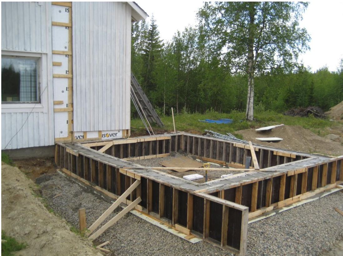
KUVA 4. Perustuksien muotit ja valu
