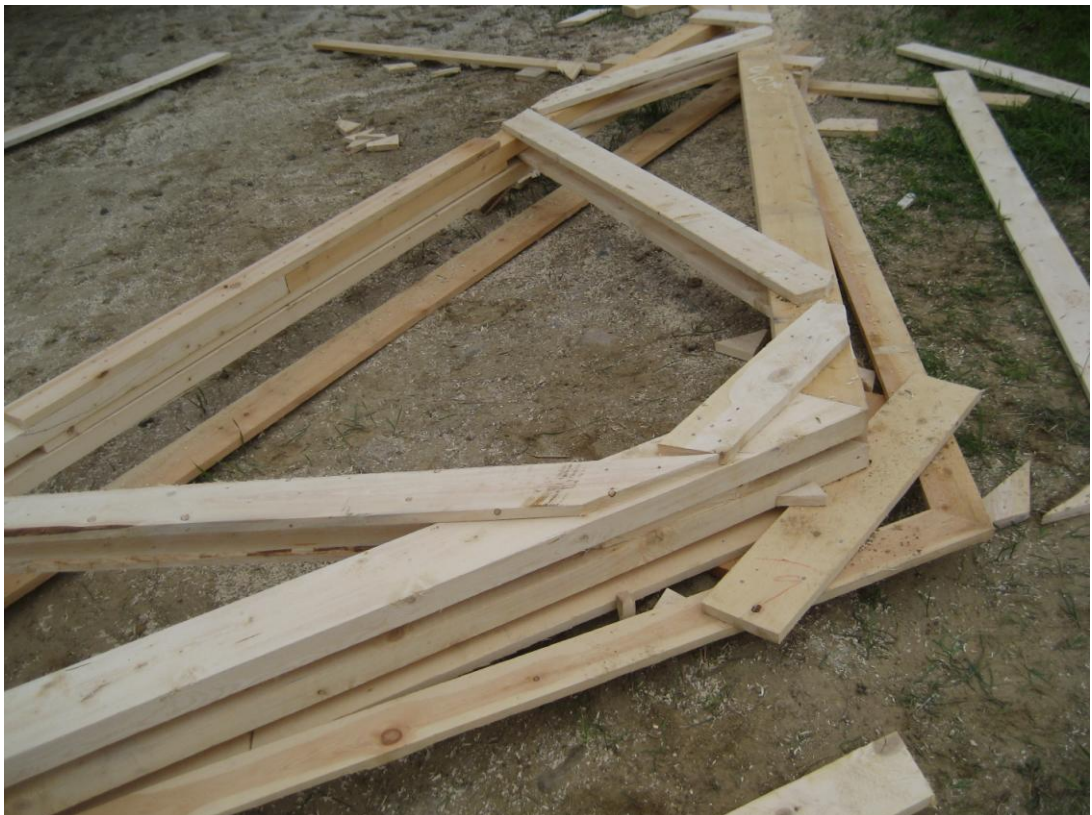
KUVA 5. Paikalla tehdyt kattotuolit
