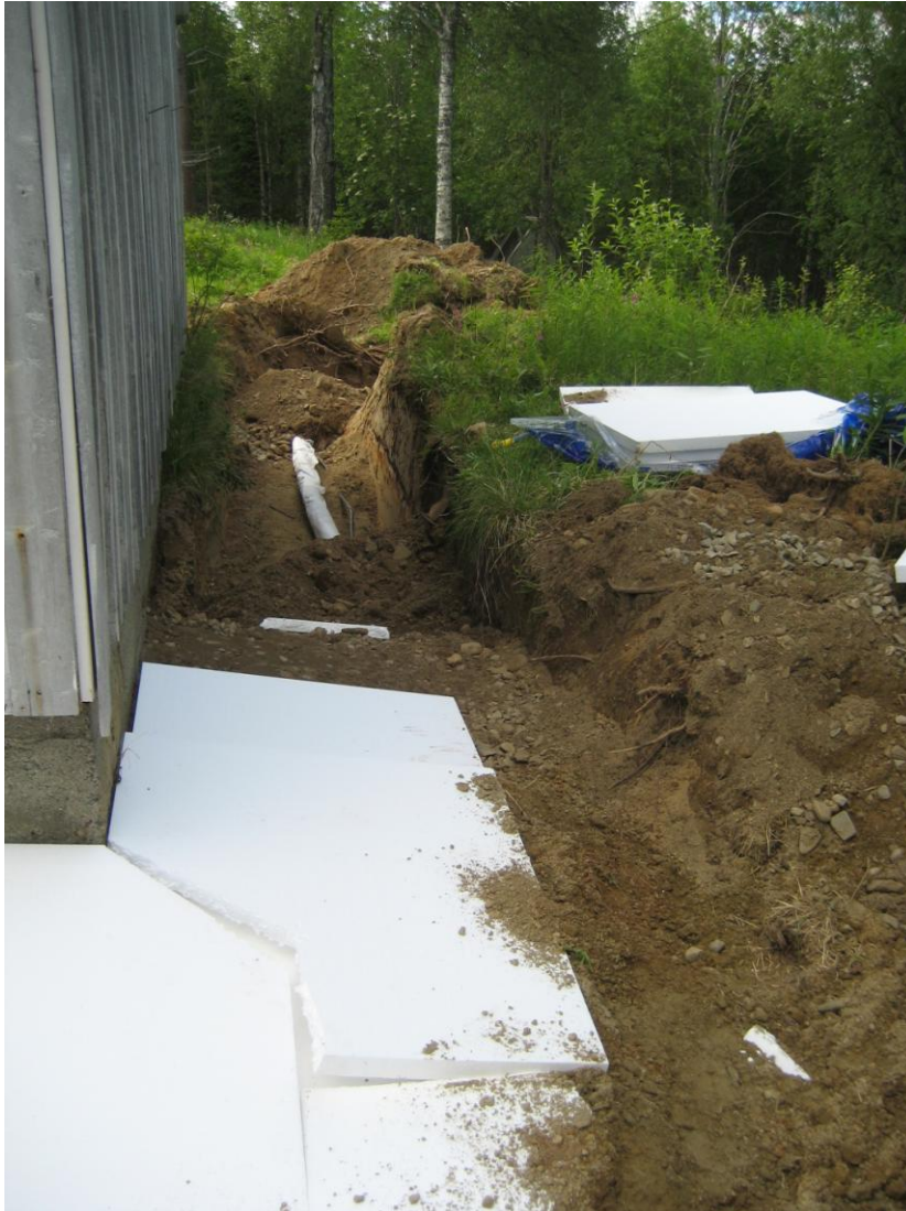
KUVA 3. Vanhan rakennusosan salaojitus ja routaeristys
