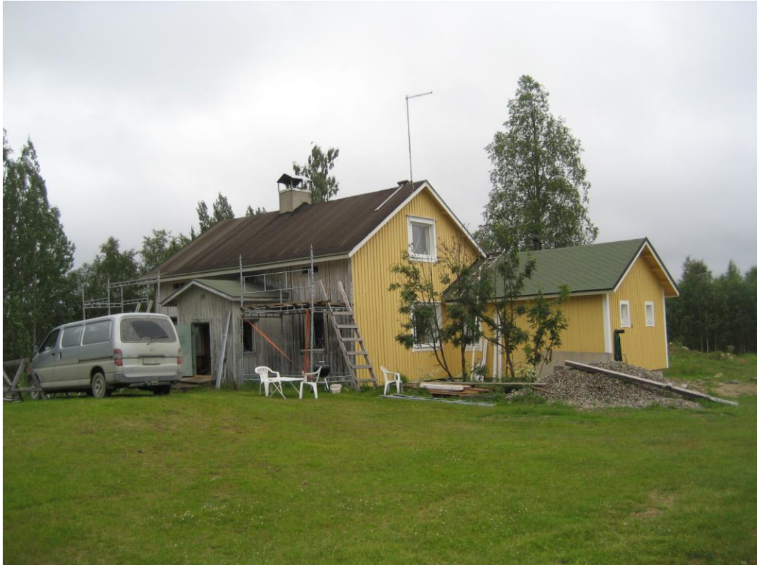
KUVA 1. Alkuperäisen rakennuksen perusparannus kesken.
