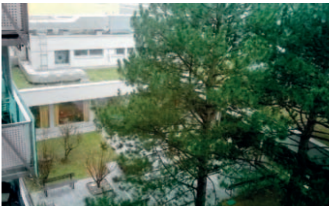
Hoivaosaston asukkaat viettivät aikaa yhteisissä tiloissa. Näkymä senioritalon sisäpihalle, talo on matalampi etelän puolelta.
