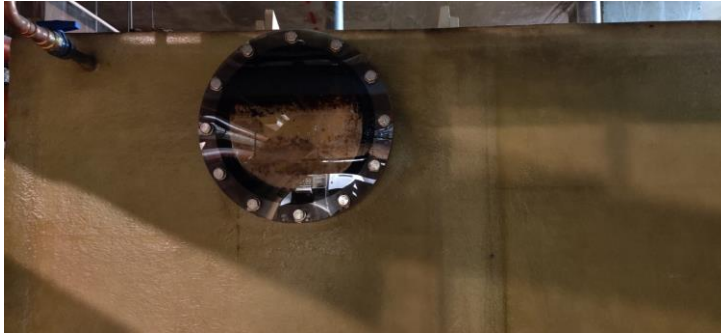
Kuva 30. Tarkastusluukku rasvanerotuskaivon kyljessä
