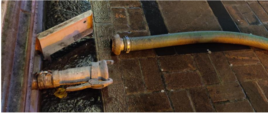
Kuva 22. Imuputken pää katutasolla
