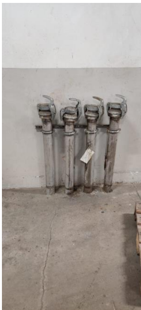
Kuva 17. Tyhjennysimuputkien liitos autolle
