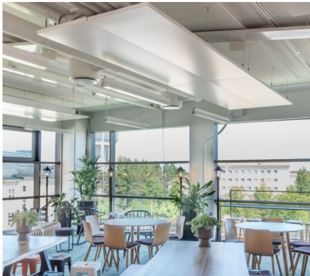
Kuvio 13. Lämmitys- ja jäähdytyspaneeli tilan katossa (Itula n.d.)
