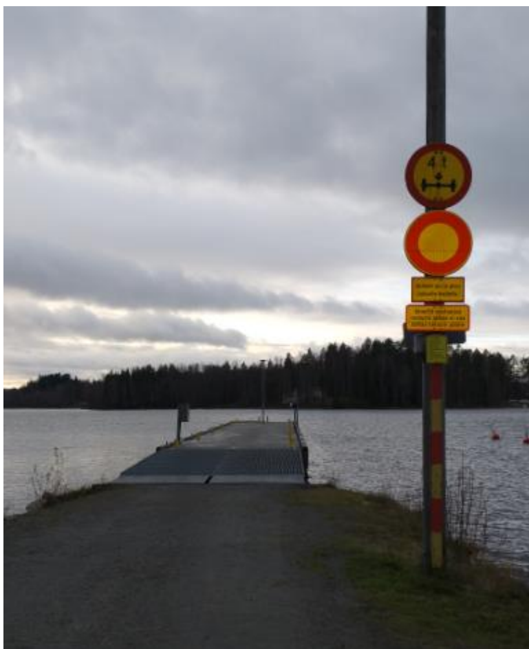
Kuva 16. Vierasvenelaituri, Vuorela. Savolainen 2020.
