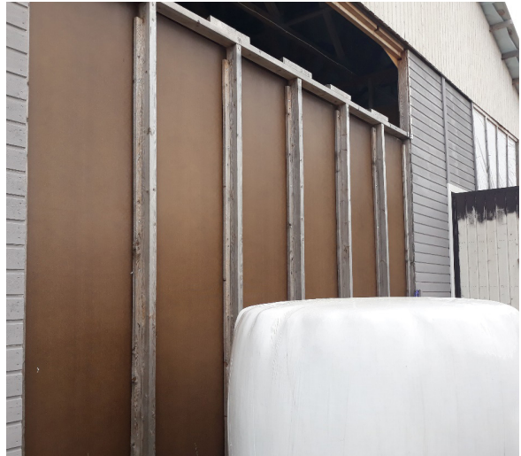
Kuva 2. Tallin 2 lantalalan purettava etuseinä
