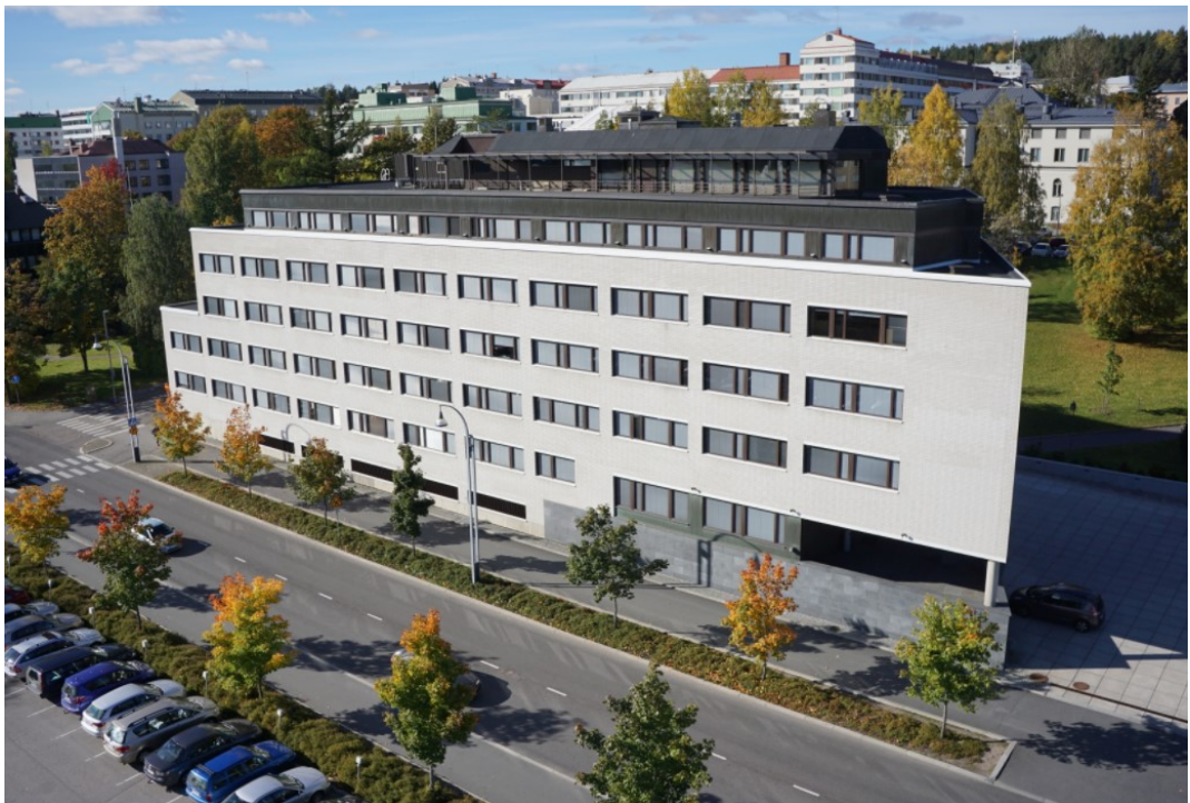
Kuva 5. Ilmakuva rakentajantalosta, rakennusvalvonta sijaitsee rakennuksen ensimmäisessä kerroksessa (Jyväskylän kaupunki 2020)
