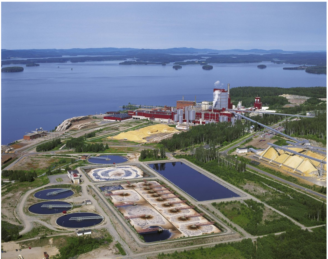
Kuva 1 . Stora Enso Enocellin tehdas. (Stora Enso Oyj 2012).
