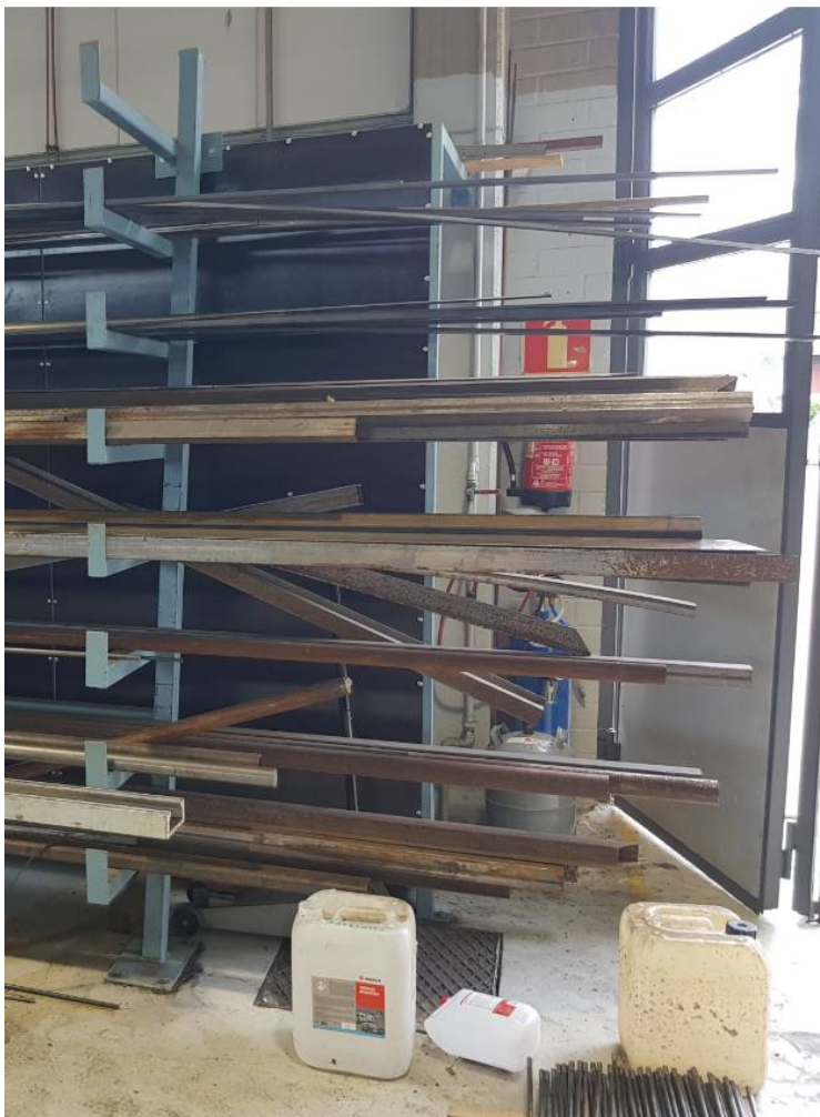
Kuva 6. Hallin ulko-ovi ei avaudu kunnossa.
