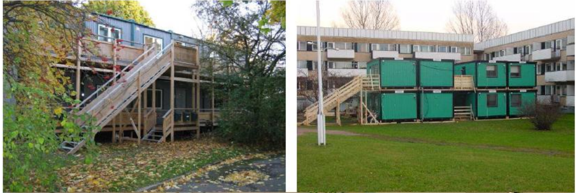
KUVAT 2 & 3. Väliaikaisasumista remontin aikana. (Kuvat: Marja Kallio, RealCase Oy 2010)
