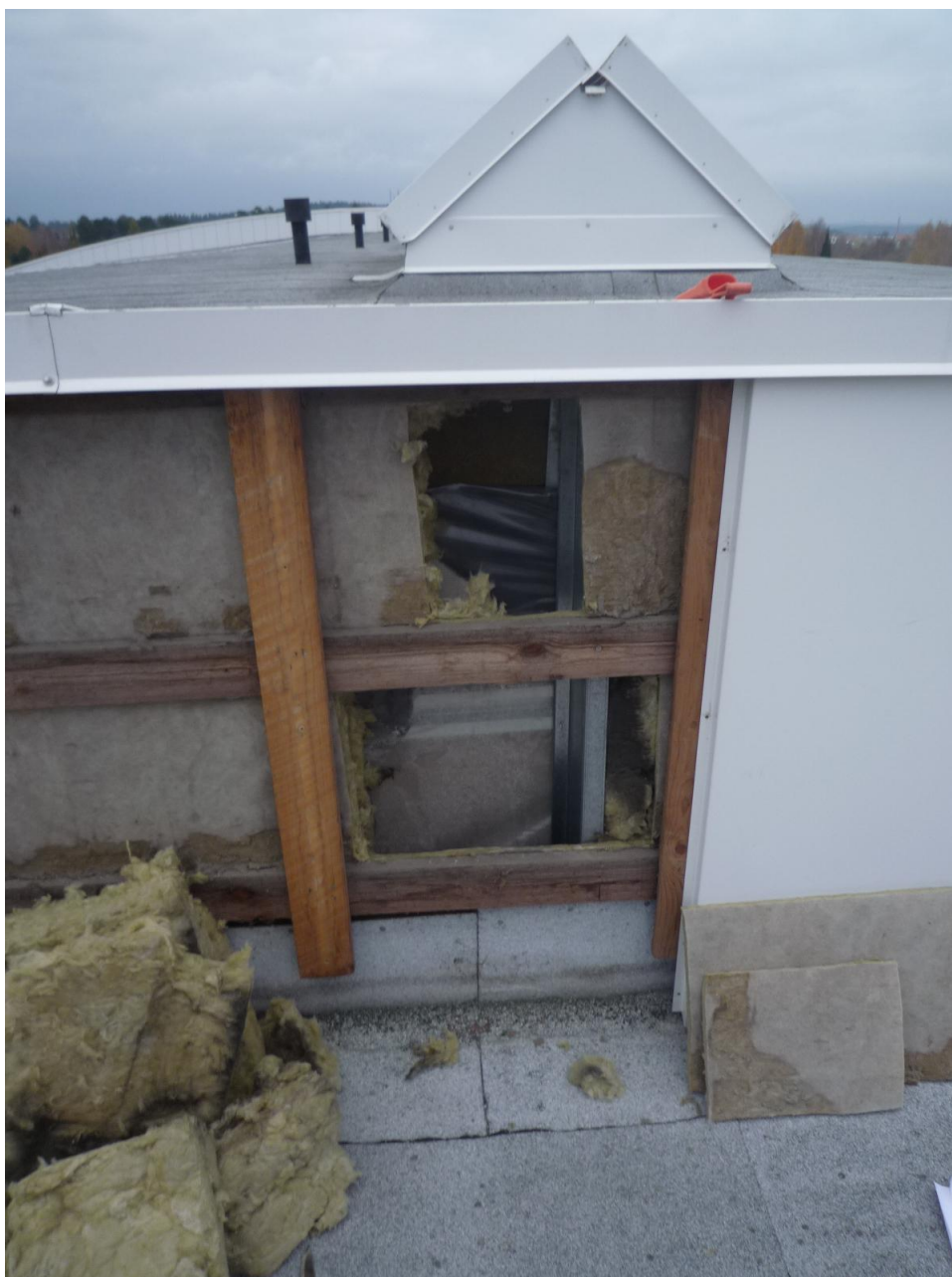
Kuva 36. Rakenne aukaistu moduulilinjan C kohdalta. Kuva Petteri Kuokkanen
