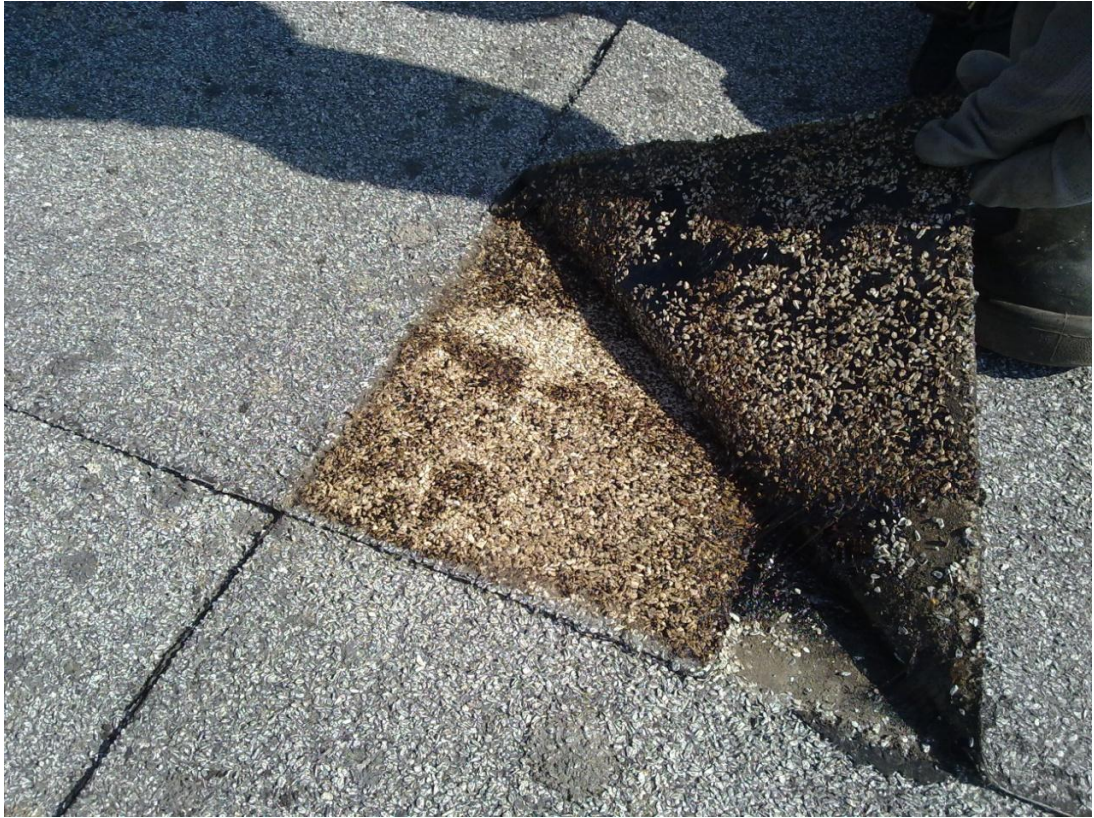
Kuva 21. Kermi irttavat saumoistaan. Kuva Petteri Kuokkanen
