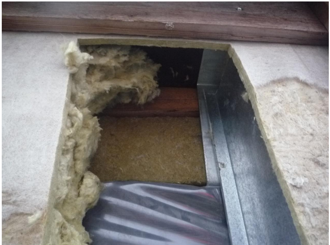
Kuva 38. Seinärakenteen yläosa. Kuva Petteri Kuokkanen
