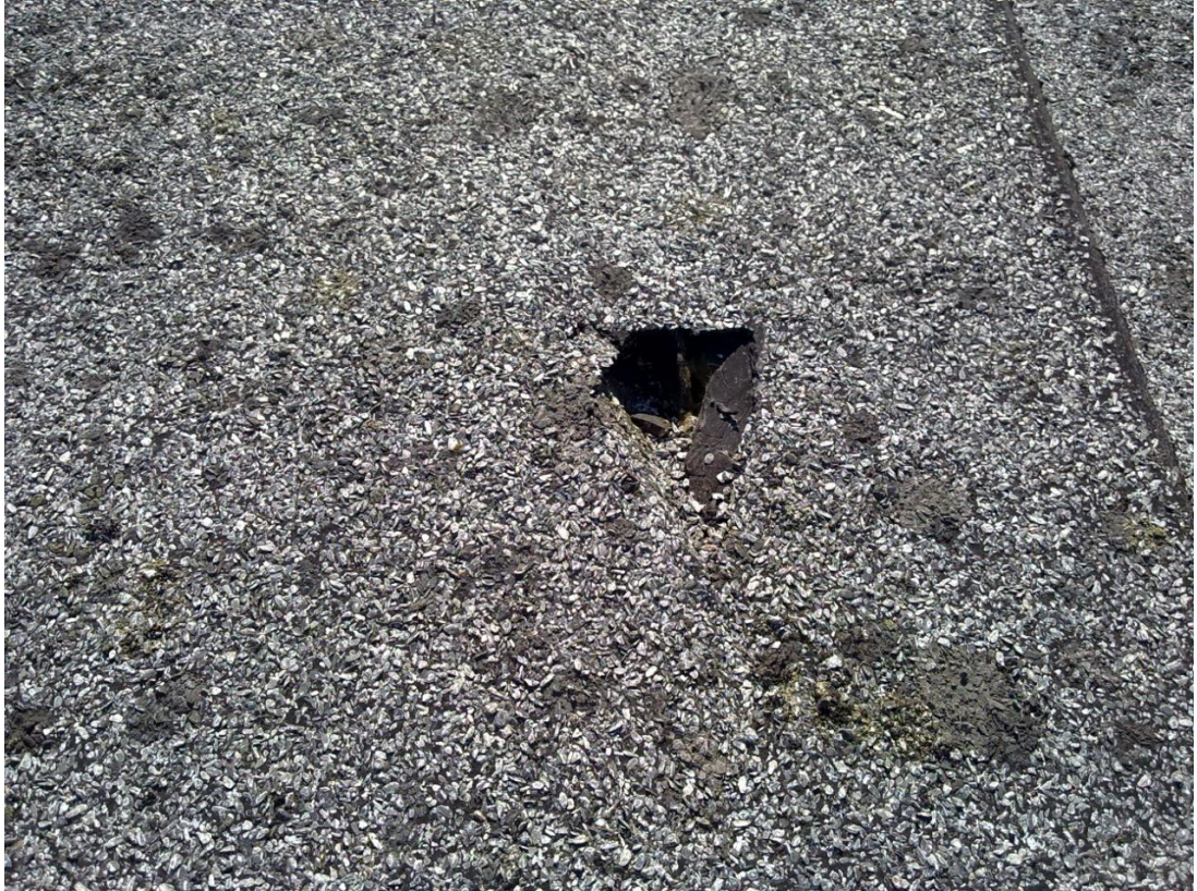
Kuva 23. Molemmat kermit lävistävä reikä. Kuva Petteri Kuokkanen
