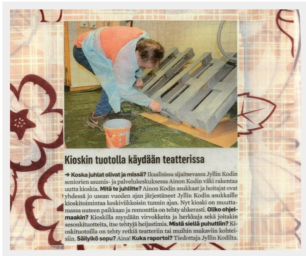
Kuva 5. Muisto Kioski Herkku-myyntikojun rakennusprojektista (Kioskin tuotoilla käydään teatterissa 2020, 21.)
