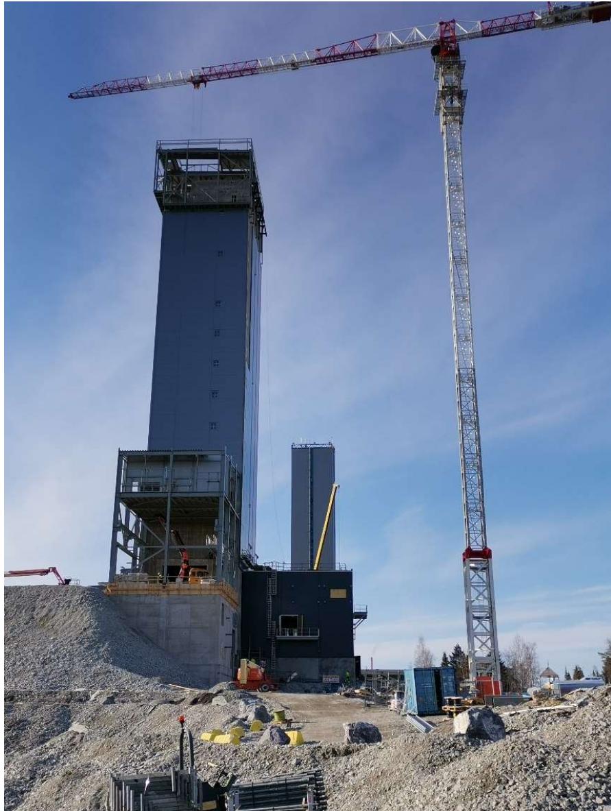
Kuva 4. Uusi nostotorni rakentuu nykyisen käytössä olevan nostotornin läheisyyteen. Kuva otettu toukokuussa 2020 (DeepMine 2020)
