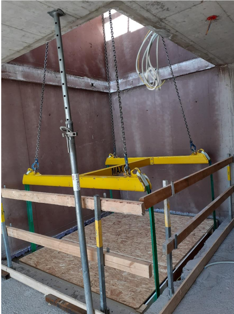
KUVA 8. Tekniikkastudiota lasketaan torninosturin varassa olevan nostoraksin avulla asennuskulussa
