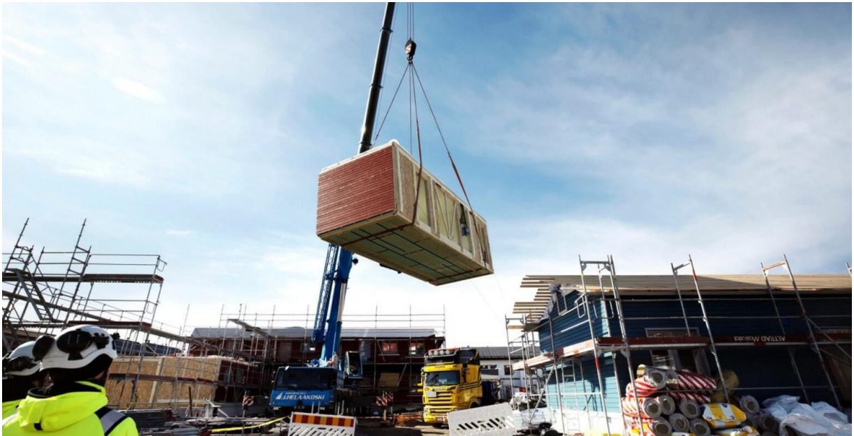
KUVA 1. Kerrostaloon tulevan yhden asunnon kokoisen tilaelementin nostotyö käynnissä (6)
