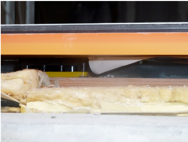
KUVA 5. Kynnyksen keskellä olevat 3mm (keltainen) ja 15 mm (musta) elementtiasennuspalat
