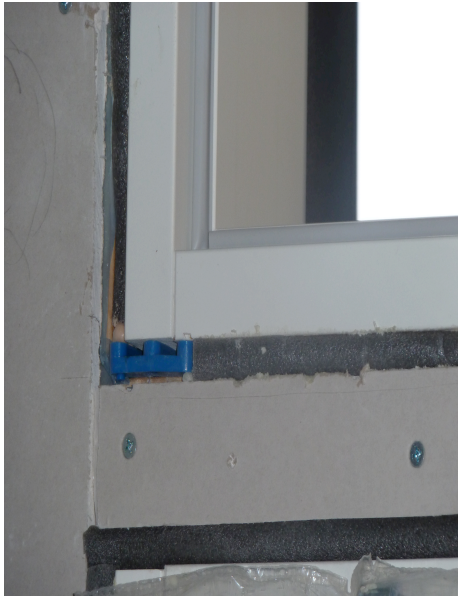
KUVA 2. Oven karmien nurkkaliitoksen tuenta elementtiasennuspaloilla
