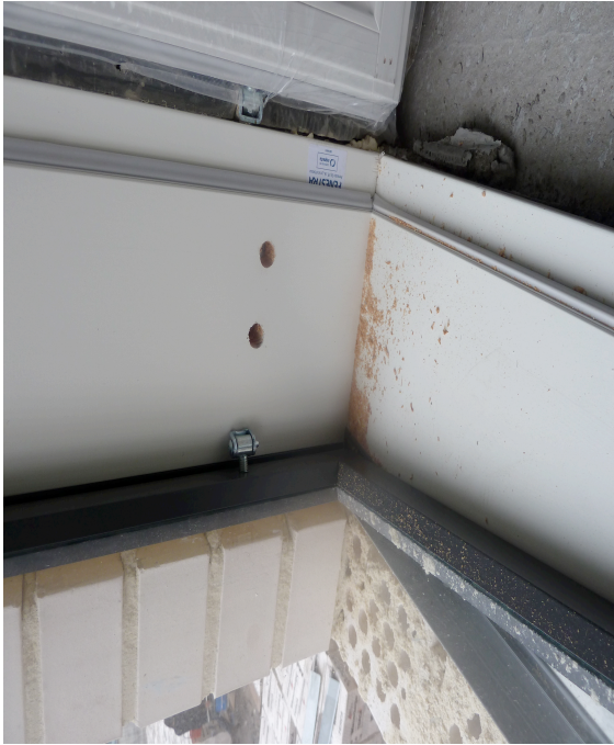
KUVA 6. Ranskalaisen parvekeoven karmin alaosaan porattu lisäreikä ruuvia varten
