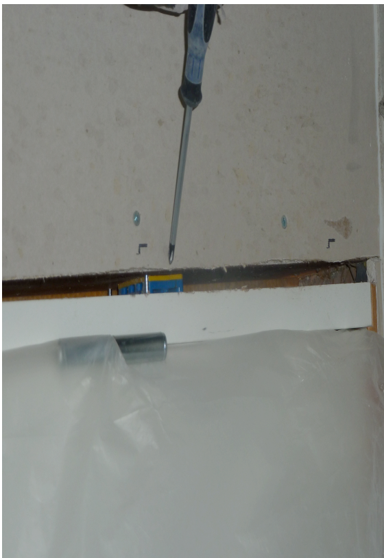
KUVA 7. Parvekeovikarmin tuentaa elementtiasennuspaloain saranan kohdalta
