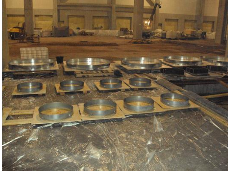
Kuva 3. 600mm muottien pohjan peitimme rakennusmuovilla, joten laatat irtosivat todella helposti ja muotit säilyivät ehjinä.
