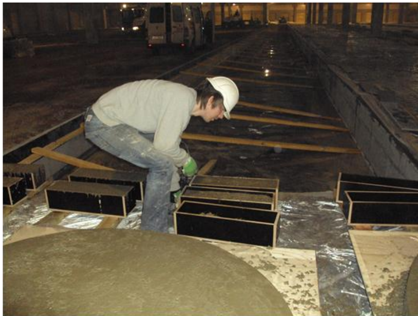
Kuva 6. Pienet muotit sijoitimme suurien taakse, joihin siirsimme massan ämpäreillä ja kottikärryillä.
