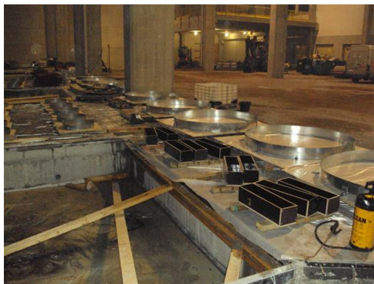
Kuva 4. Muotit sijoitettiin valualueelle tyypeittäin, mikä helpotti valua sekä valmiiden muottien merkitsemistä ennen siirtoa testilaboratorioon.
