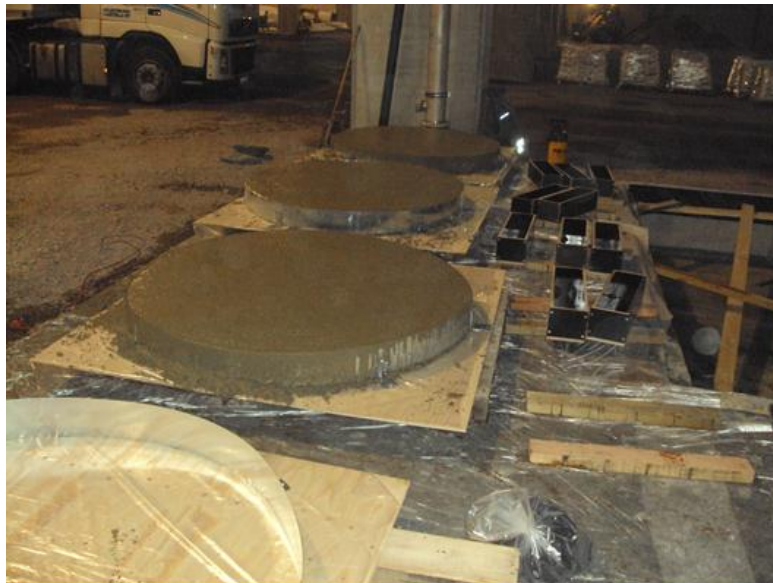
Kuva 5. Suuret muotit sijoitimme siten, että saimme betonimassan suoraan Prim-dumperista muotteihin. Tällä tavoin säästimme aikaa ja ruumiillisen työn tarvetta.
