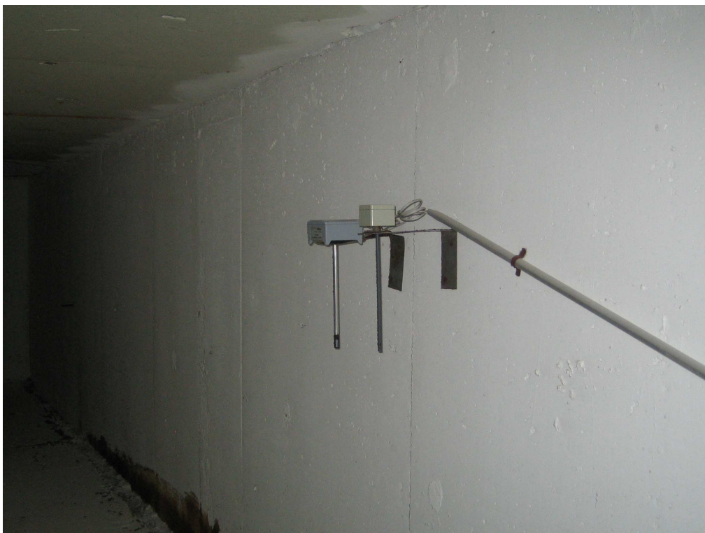
Kuva 4.3. Lämpötila- ja kosteusanturit poistoilmakanavassa
