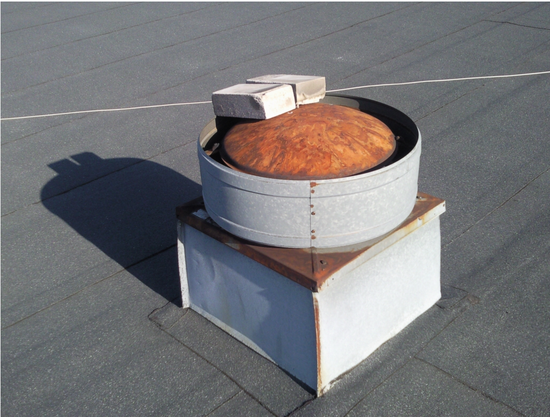
Kuva 3. Konttoritilojen poistoilmapuhallin.
