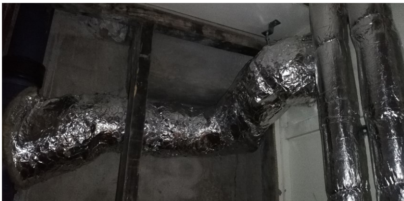
Kuva 8. Kannakoinnin ja eristyksien tarkastus
