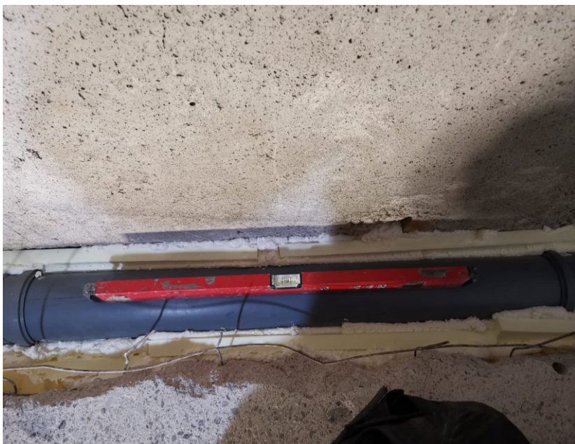
Kuva 9. Viemärin kaatojen tarkastus
