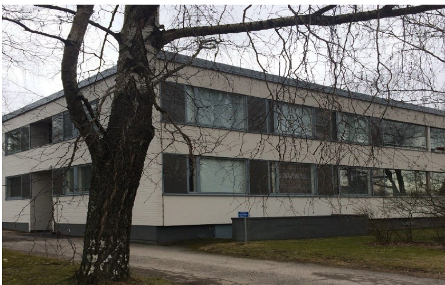
As. Oy Konalantie 1
