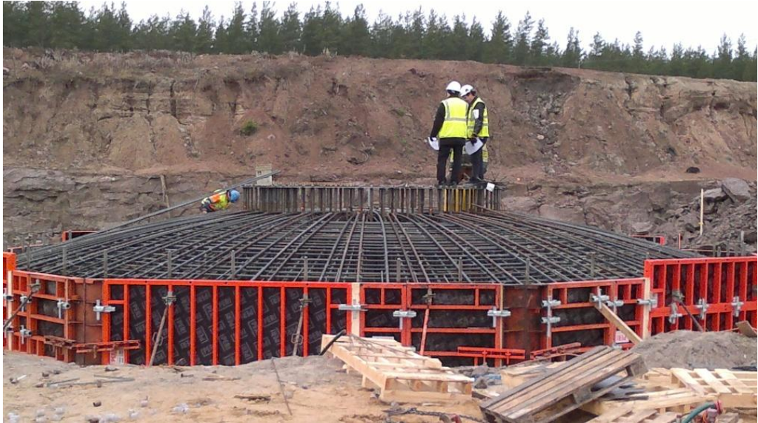
Kuva 10. Mäkelänkankaan voimalan perustukset 24.11.2011 (38).
