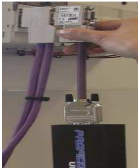
Kuvio 5. Laitteiston asennus DP-mittaukseen. (Procentec 2011, 32)
