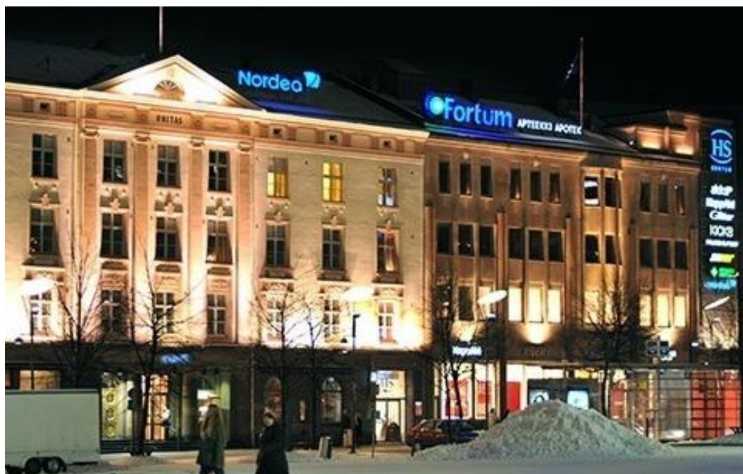
Figur 8. Fasadbild, gamla och nya delen sett från Nedre torget. 62
