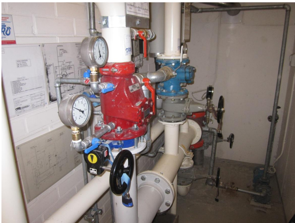
Figur 18. Sprinklersystemets central.
