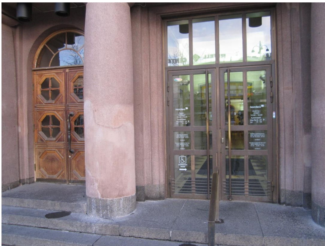
Figur 12. Ingången till Nordea i den gamla byggnaden. Originaldörr ur bruk till vänster, ny till höger.
