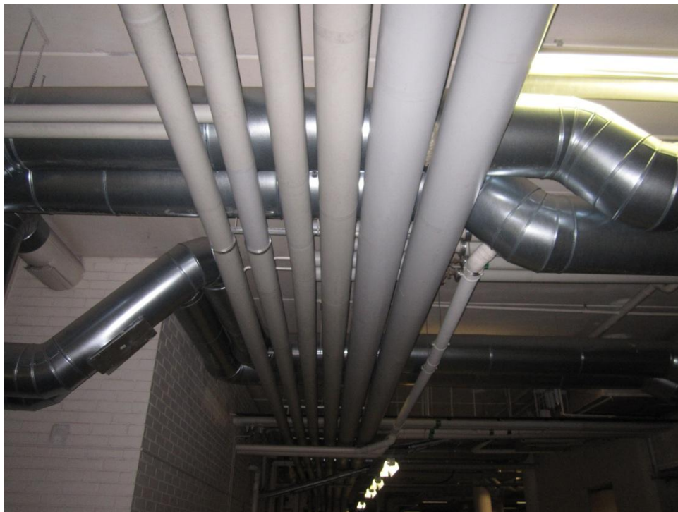
Figur 17. Rödrugning i parkeringshallen i källaren.
