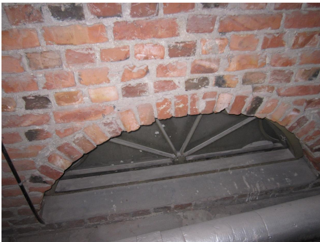
Figur 13. Vinden i gamla byggnaden. Stomme av originaltegel.
