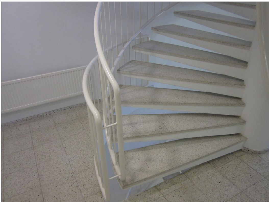
Figur 22. Trappor i nya byggnaden.
