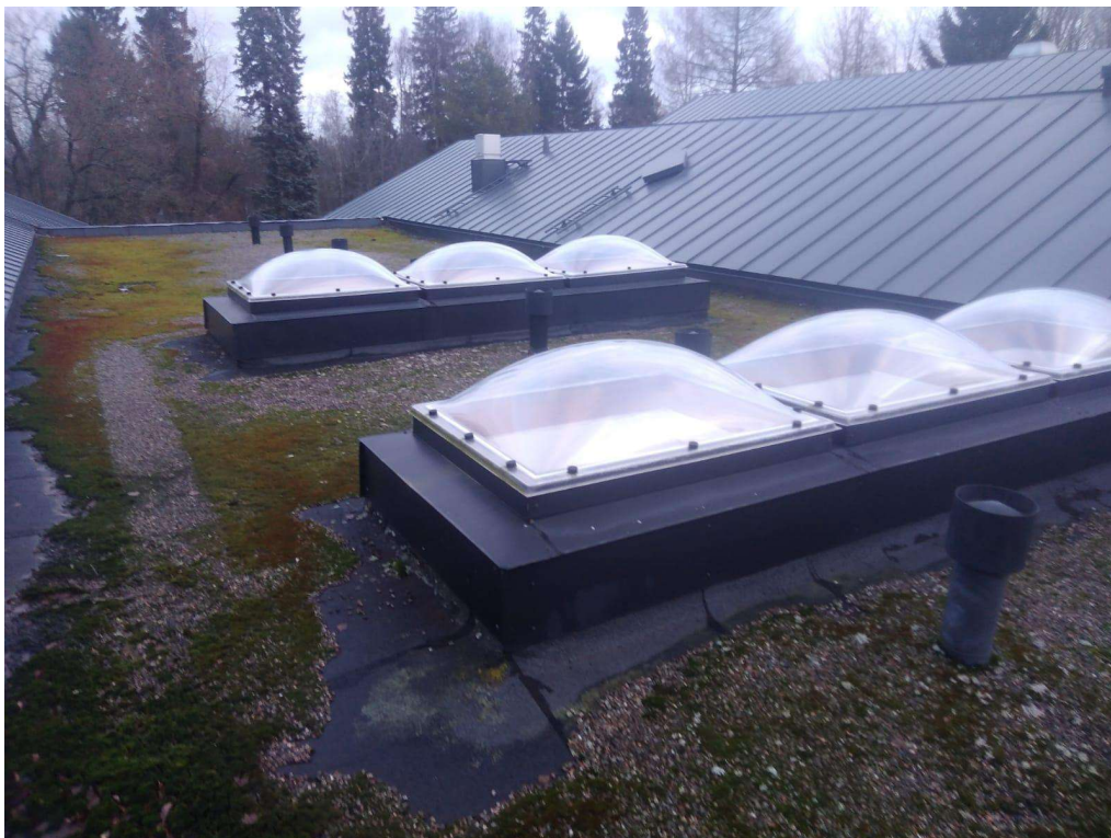
Kuva 9. Tasakaton osuus, jossa on bitumikermikate. Tasakatto-osuus sijaitsee pitkittäin keskellä päärakennusta. Lähde E.Vahala
