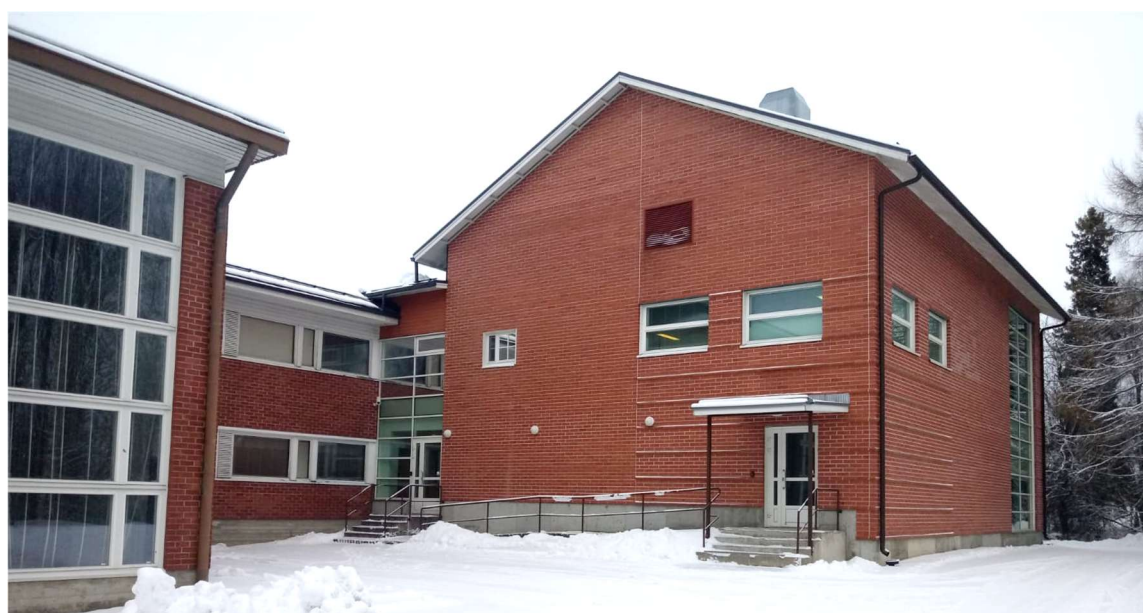
Kuva 4. Päärakennuksen (vasemmalla) ja auditorion liittyminen. Lähde E.Vahala
