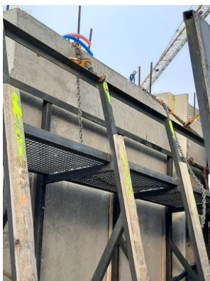
Kuva 49. Kuljetusajoneuvossa väliseinäelementin kiinnitys A-pukkiin ketjujen ja vanttiruuvien avulla.
