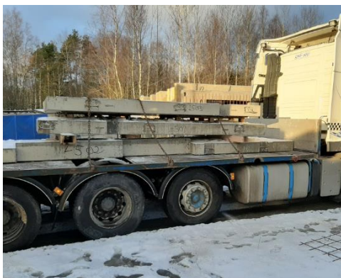
Kuva 50. Massiivilaattojen lastaus kuljetusajoneuvoon.
