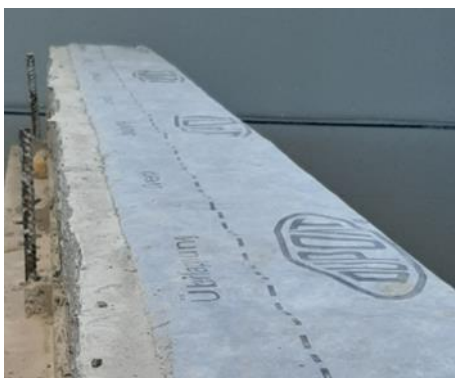
Kuva 34. SK-elementin yläosan lämmöneristeiden suojaus Tyvek-kankaan avulla.
