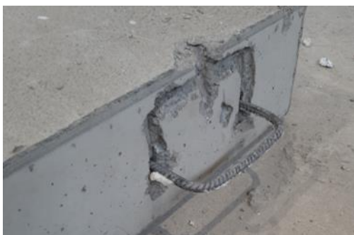
Kuva 18. Massiivilaattojen tartuntateräs väännetty oikeaan asentoon
