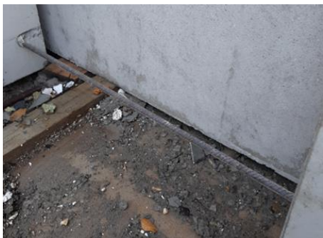
Kuva 29. Väliseinäelementin oviaukon kuljetustuki.
