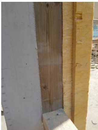
Kuva 35. Ikkuna-aukkojen eristeiden leikkaaminen.
