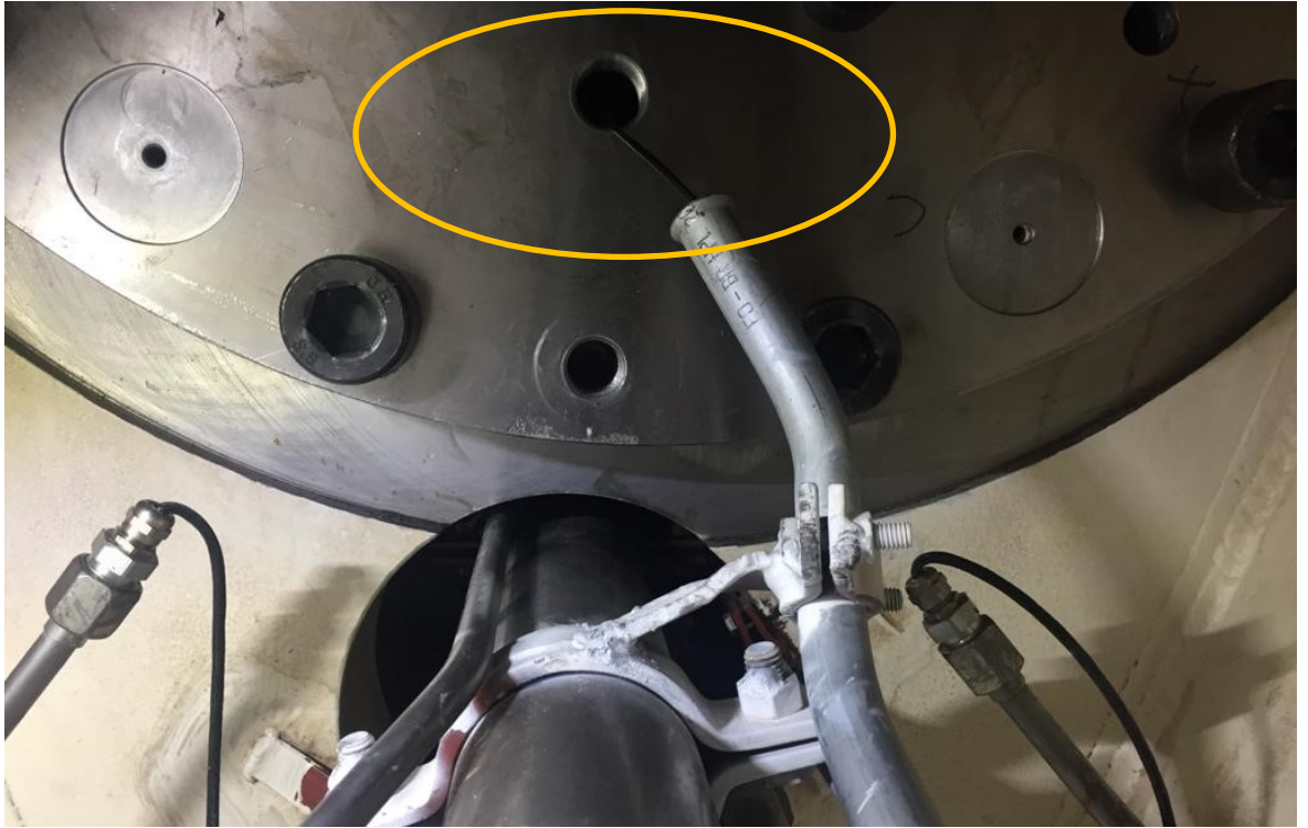
Kuva 18. Tukilaakerin valokuitukaapelin putkitus (Peltonen sähköposti 27.11.2020)
