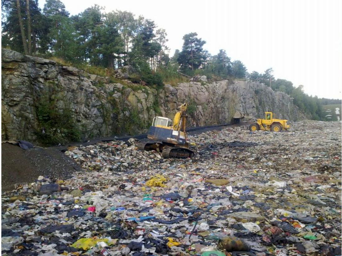
Kuva 9. Valmiin pystyeristeseinän peittämistä
