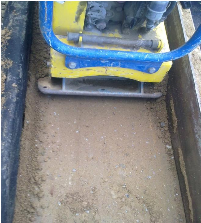
Kuva 6. Mineraalisen tiivisrakenteen tiivistämistä muottiin
