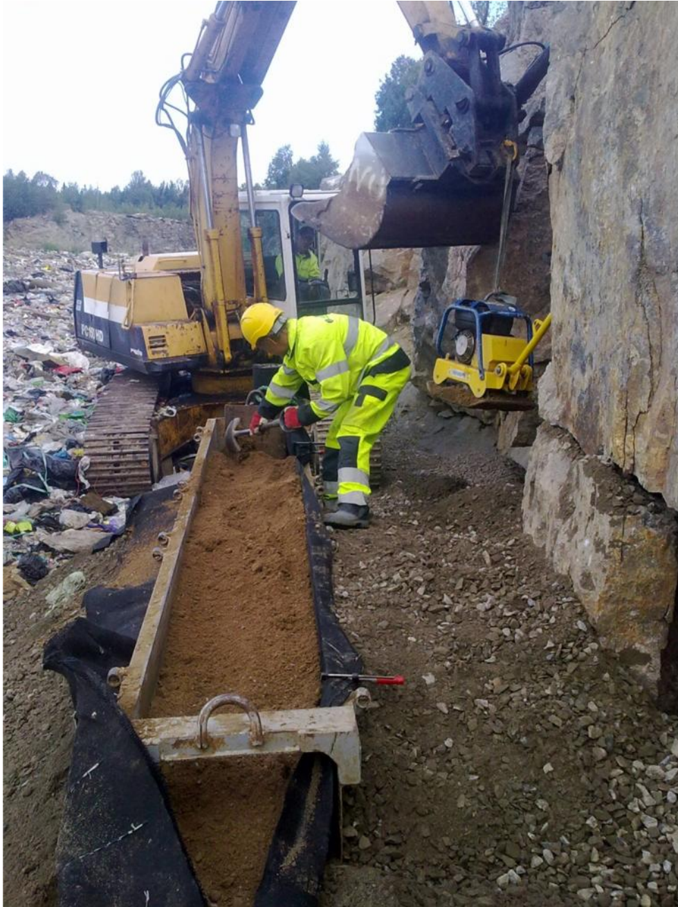
Kuva 5. Mineraalieristeen tasoitus ennen tiivistystä
