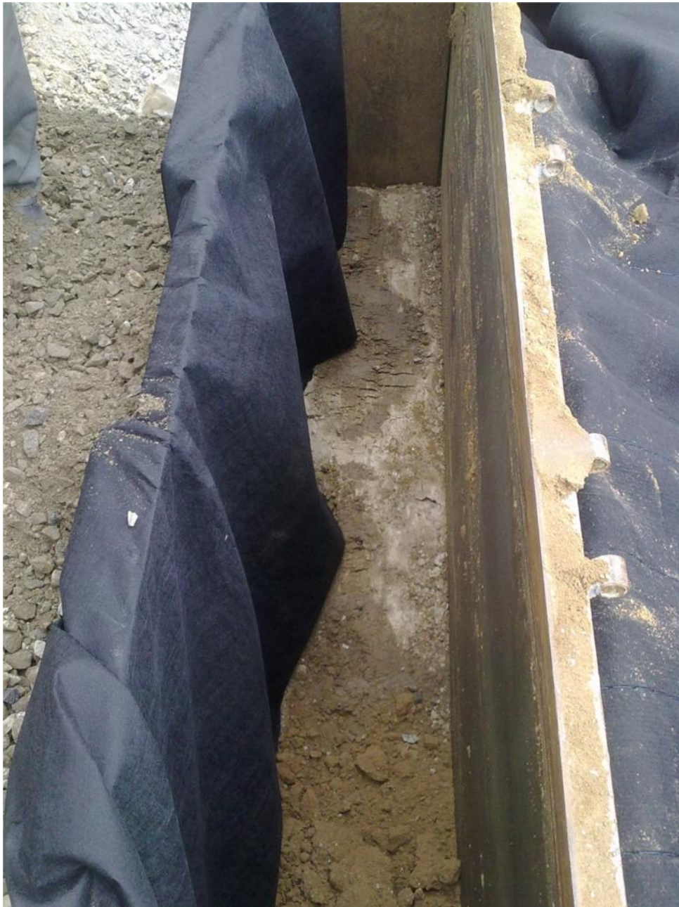
Kuva 4. Muotti paikoillaan ja geosynteetit asennettuna
